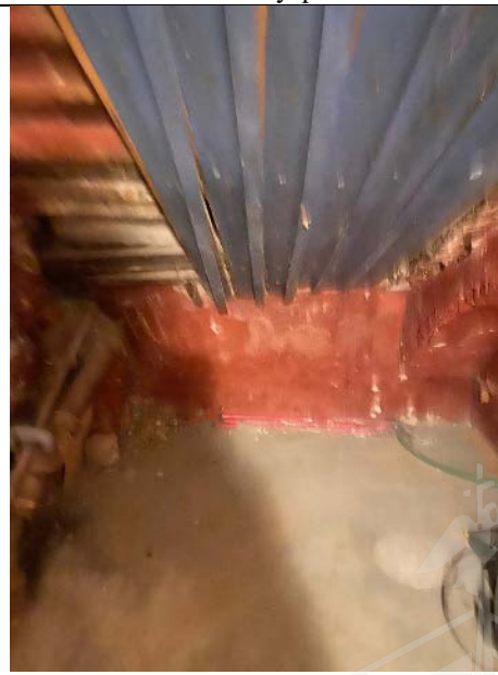
Фото № 18 - Внутреннее состояние
