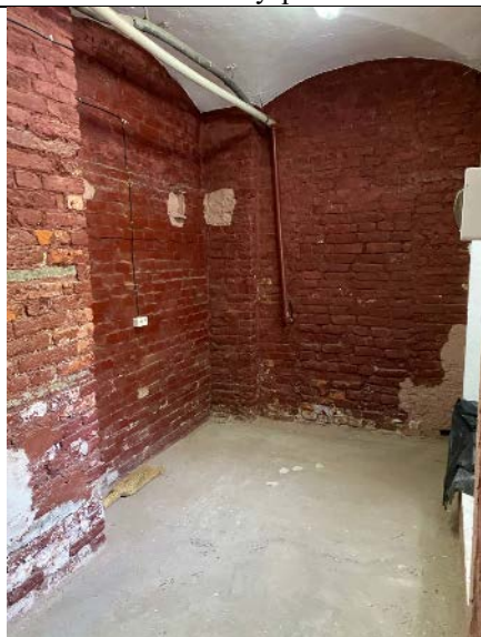
Фото № 11 - Внутреннее состояние
