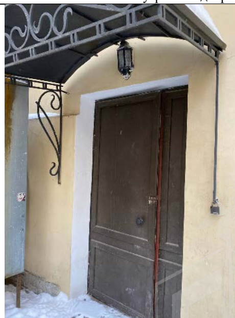
Фото № 6 – Общий вход в помещение со двора
