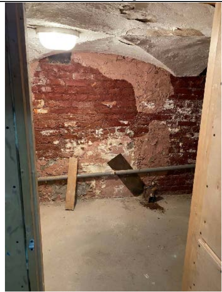
Фото № 16 - Внутреннее состояние
