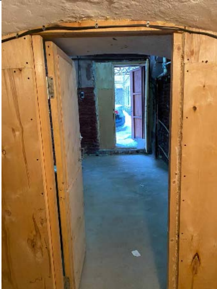
Фото № 13 - Внутреннее состояние
