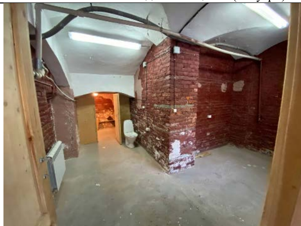
Фото № 9 - Внутреннее состояние
