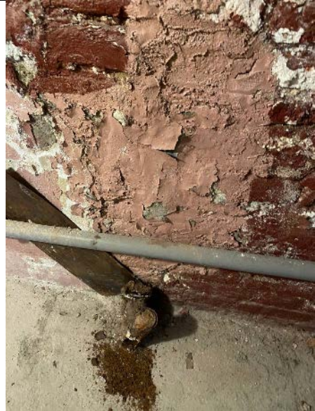
Фото № 14 - Внутреннее состояние
