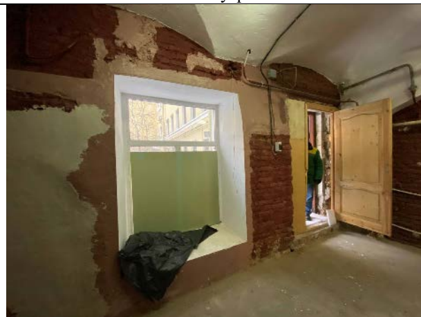
Фото №10 - Внутреннее состояние
