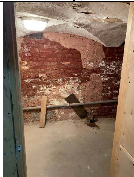
Фото № 16 - Внутреннее состояние
