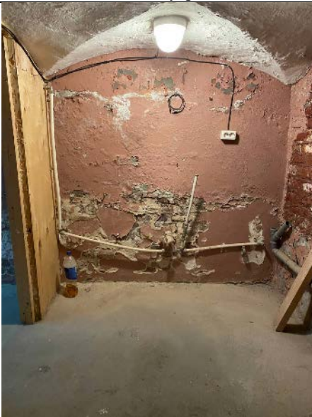
Фото № 15 - Внутреннее состояние
