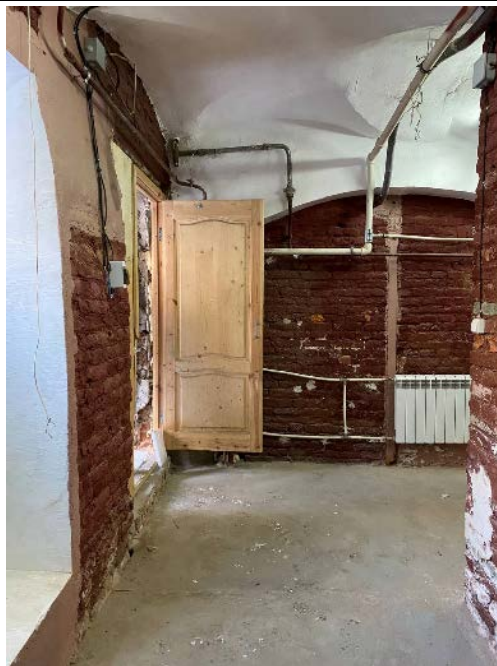
Фото № 8 - Внутреннее состояние
