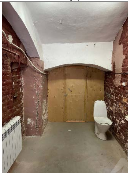
Фото № 12 - Внутреннее состояние
