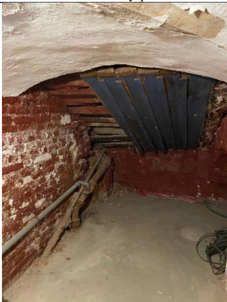
Фото № 17 - Внутреннее состояние
