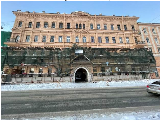
Фото 7. Вид здания расположения Объекта оценки
