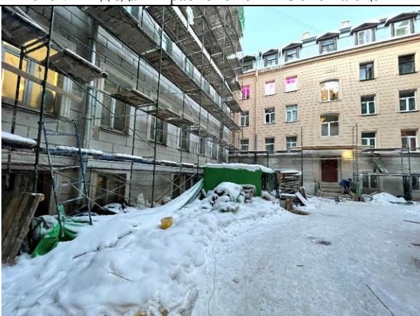
Фото 9. Внутри дворовая территория Объекта оценки
