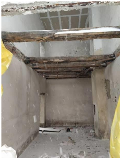
Фото 5-6. Типовое внутреннее состояние помещений Объекта оценки: строительный мусор в результате разрушения (утраты) деревянных перекрытий, полов, внутренней отделки, оконных и дверных проемов и пр.
