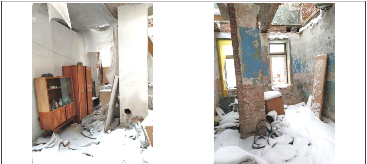
Фото 13-14. Типовое состояние внутренней отделки
