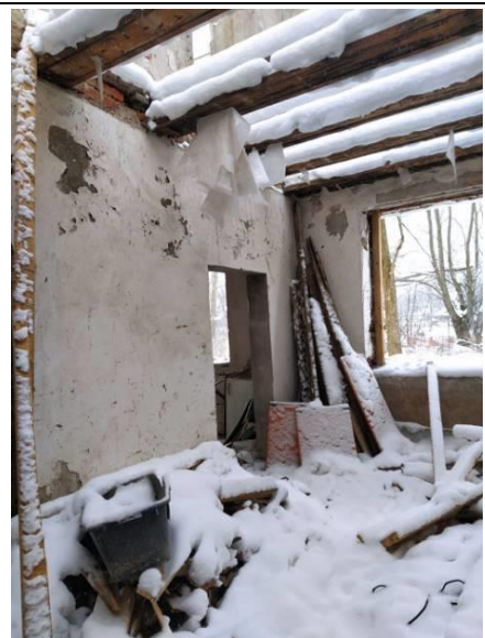
Фото 11-12. Типовое состояние внутренней отделки: отсутствие остекления оконных проемов, утрата перекрытий и кровли
