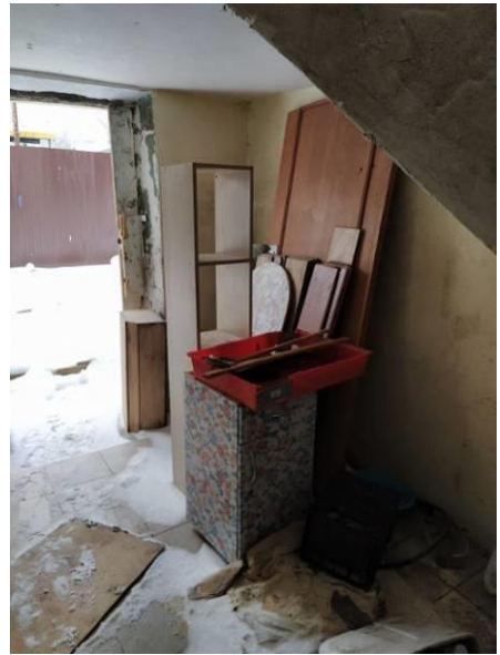
Фото 8. Типовое внутреннее состояние помещений
