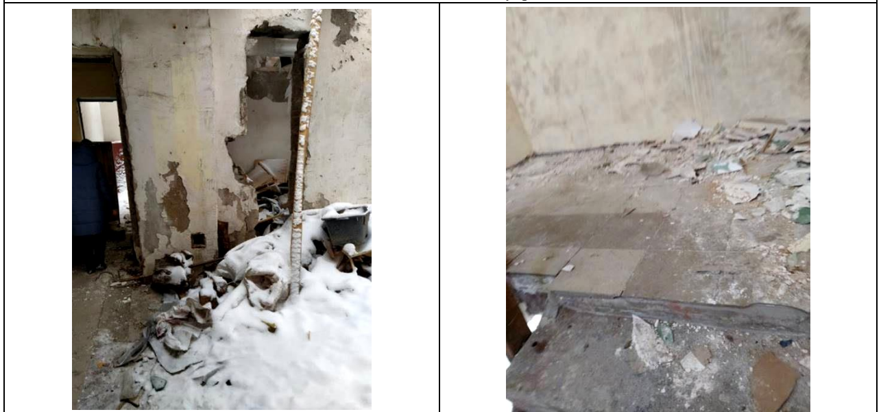
Фото 15-16. Типовое состояние внутренней отделки
