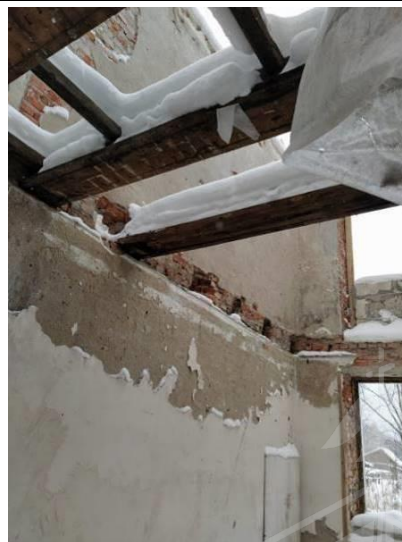
Фото 5-6. Типовое внутреннее состояние помещений Объекта оценки: строительный мусор в результате разрушения (утраты) деревянных перекрытий, полов, внутренней отделки, оконных и дверных проемов и пр.
