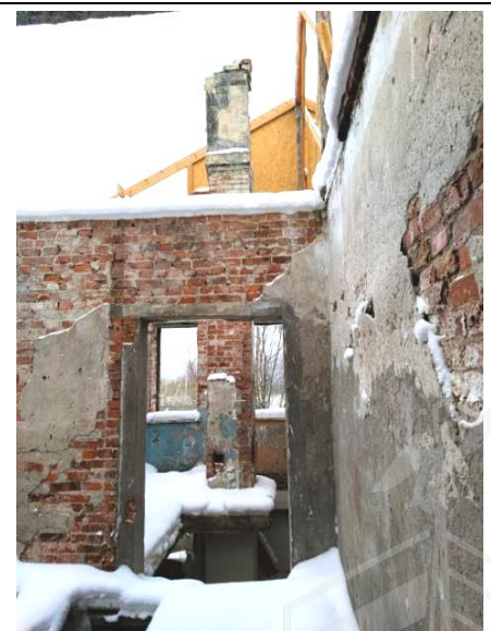
Фото 11-12. Типовое состояние внутренней отделки: отсутствие остекления оконных проемов, утрата перекрытий и кровли
