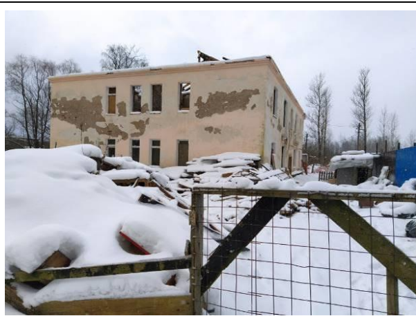
Фото 1. Вид на фасад здания Объекта оценки. Элементы ограждения
