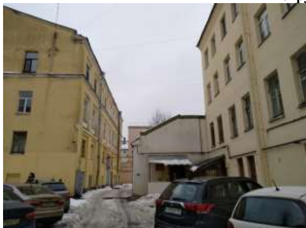
Фото 1. Вид здания, в котором расположен Объект оценки, ближайшее окружение (дворовая территория)
