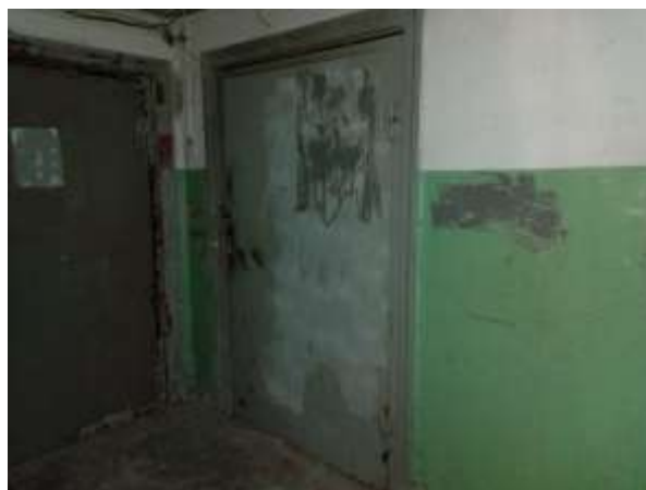
Фото 14. Вход в помещение 7-Н
