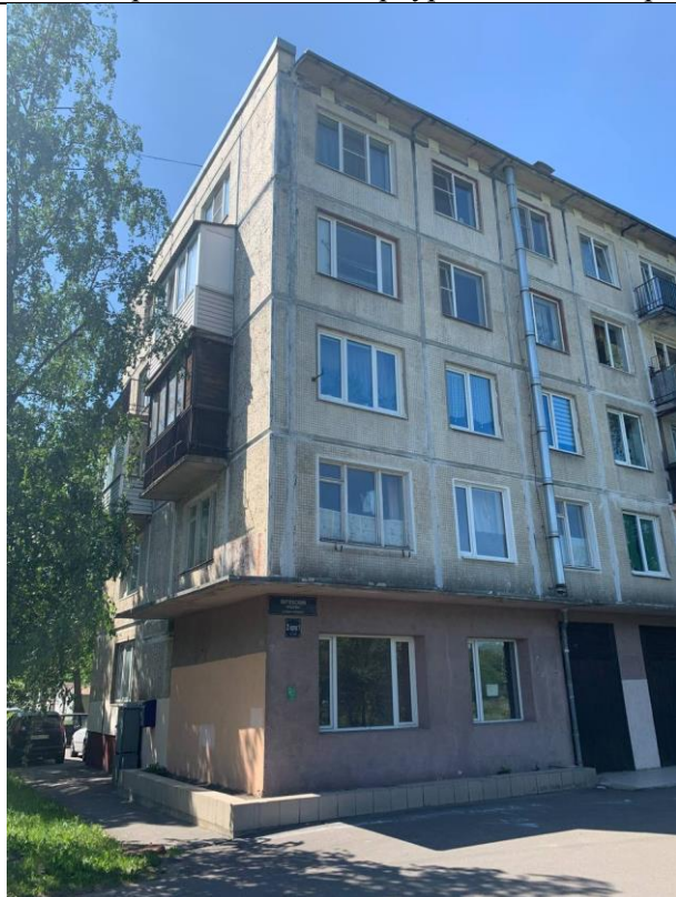
Фото № 1 – Вход в помещение со стороны Витебского проспекта
