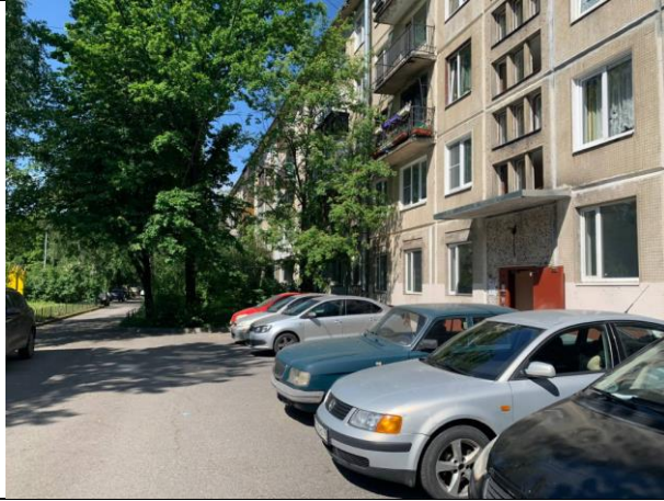
Фото № 22 – Фасад здания
