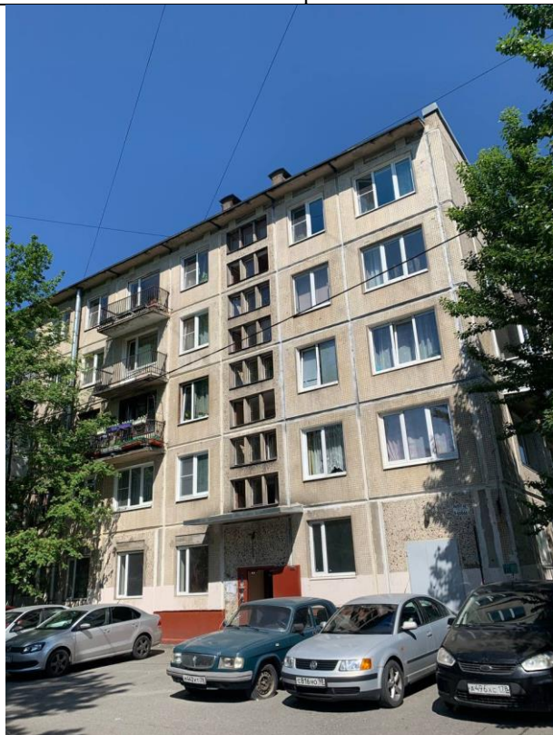
Фото № 3 – Вход в помещение со стороны проспекта Космонавтов
