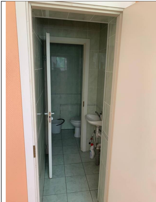
Фото № 17 - Внутреннее состояние
