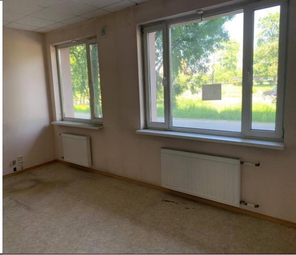
Фото № 9 - Внутреннее состояние
