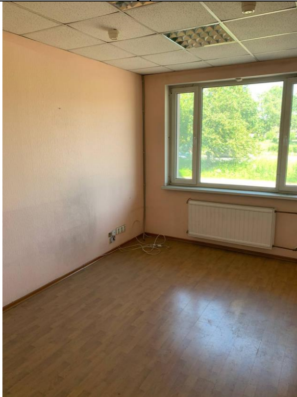
Фото № 11 - Внутреннее состояние
