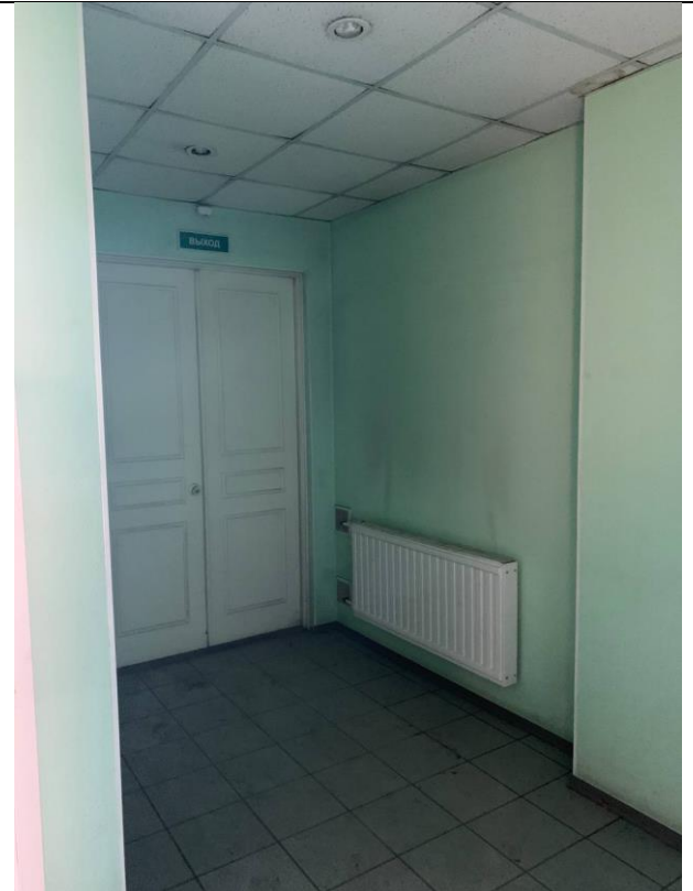
Фото № 6 - Внутреннее состояние
