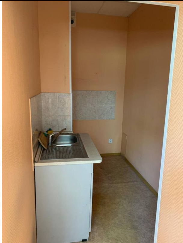
Фото № 13 - Внутреннее состояние
