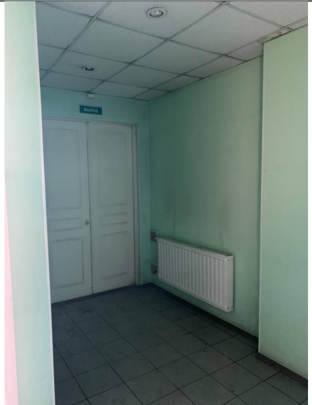
Фото № 6 - Внутреннее состояние
