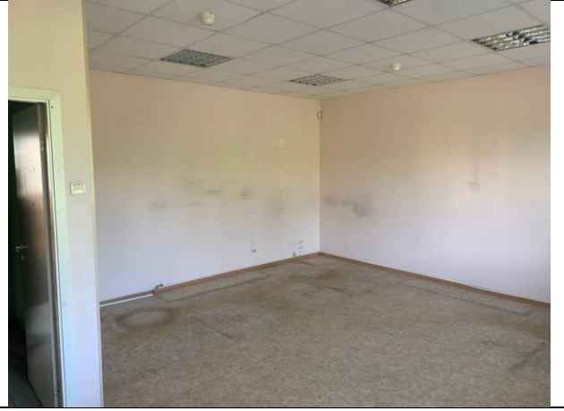
Фото № 22 - Внутреннее состояние
