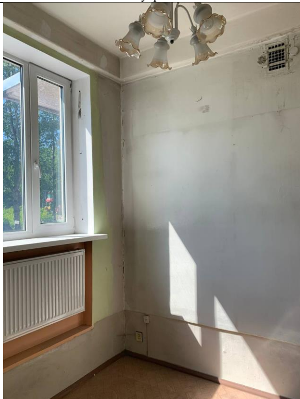
Фото № 15 - Внутреннее состояние
