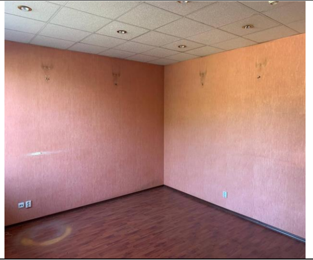
Фото №10 - Внутреннее состояние
