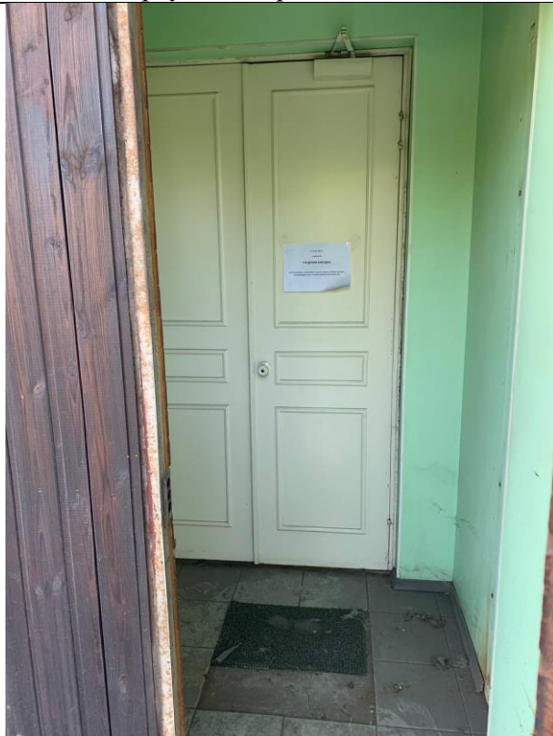
Фото № 2 – Вход в помещение со стороны Витебского проспекта
