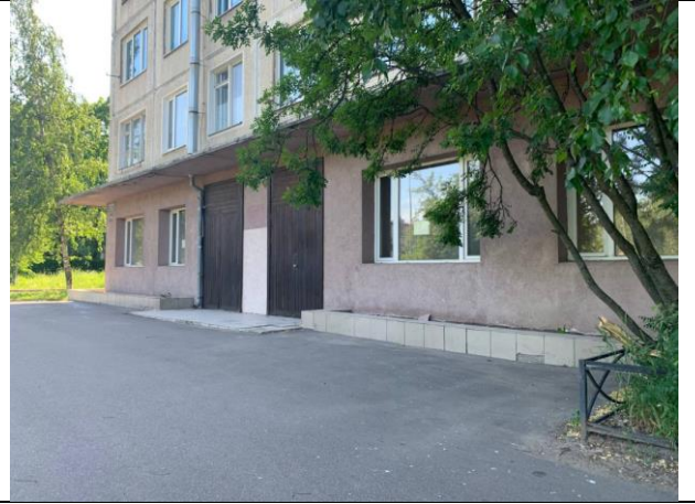
Фото № 23 - Фасад здания
