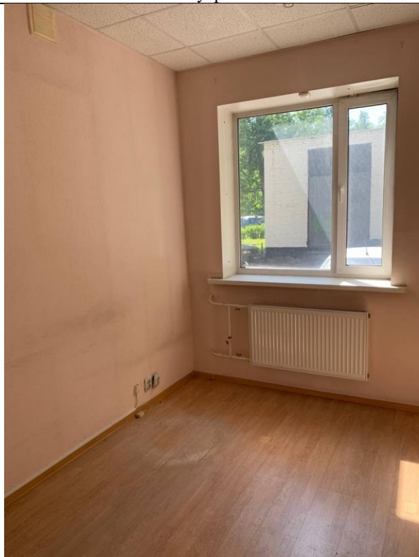
Фото № 19 - Внутреннее состояние
