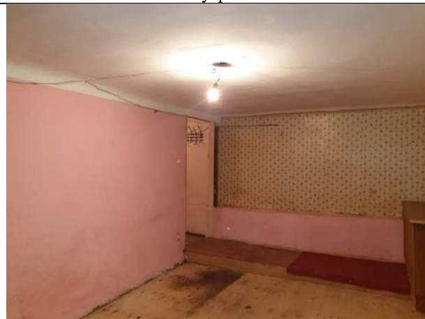
Фото № 8 - Внутренне состояние
