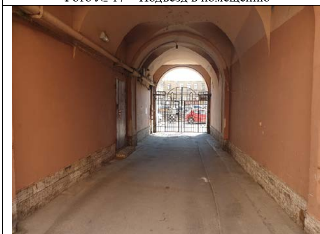
Фото № 19 – Подъезд в помещение
