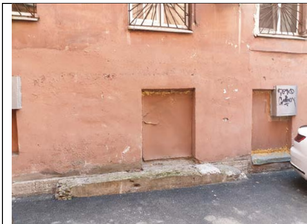
Фото № 13 – Фасад здания (внутри двора)
