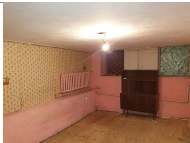
Фото № 6 - Внутренне состояние
