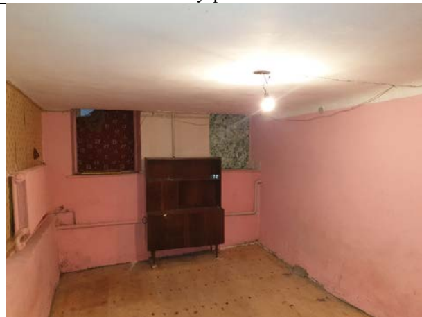
Фото № 7 - Внутренне состояние
