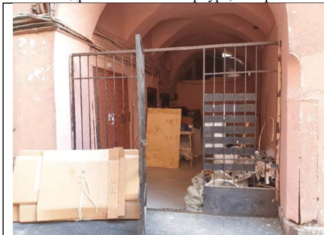
Фото № 1 – Вход в помещение
