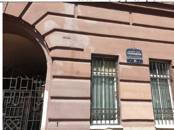
Фото № 16 - Фасад здания (снаружи двора)
