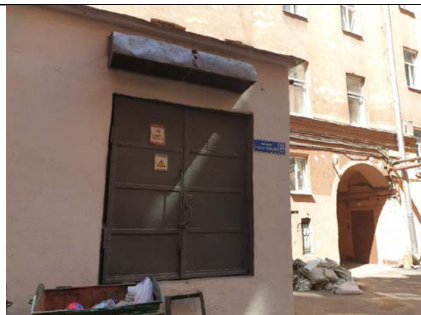
Фото № 14 - Фасад здания (внутри двора)
