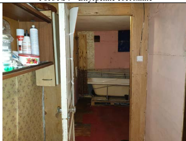
Фото № 9 - Внутренне состояние
