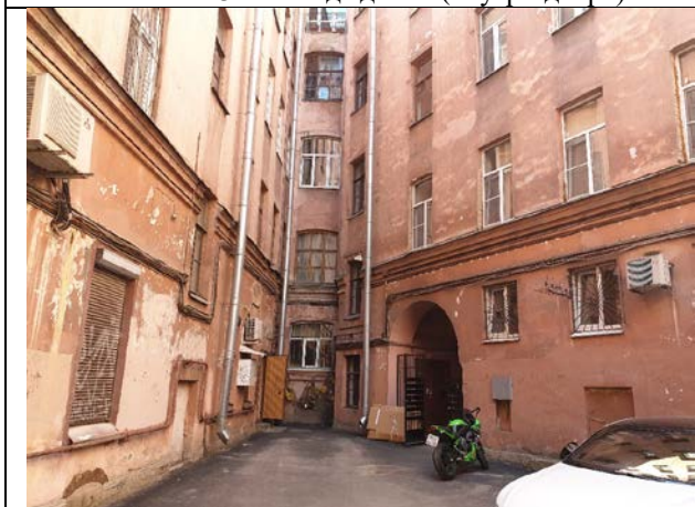
Фото № 15 - Фасад здания (внутри двора)
