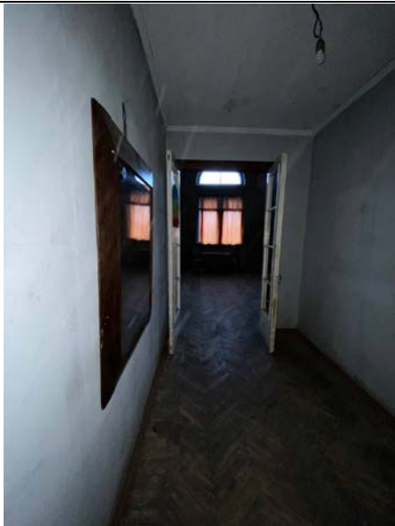
Фото № 9 – Внутреннее состояние помещения 21-Н
