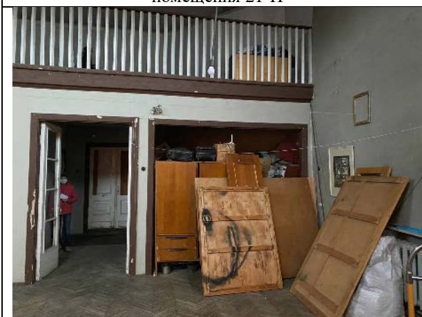
Фото № 15 – Внутреннее состояние помещения 21-Н
