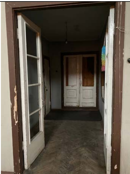
Фото № 11 – Внутреннее состояние помещения 21-Н
