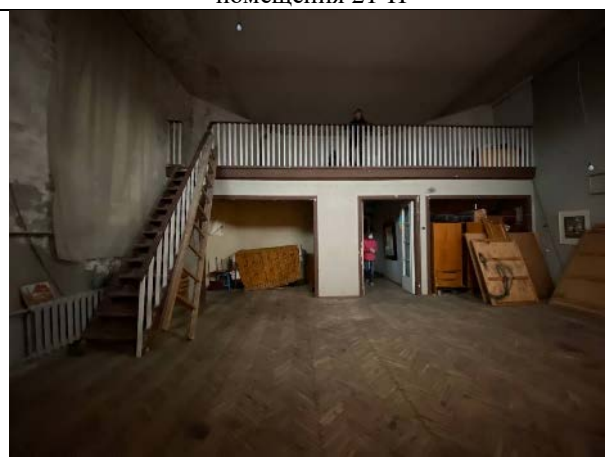
Фото № 16 – Внутреннее состояние помещения 21-Н
