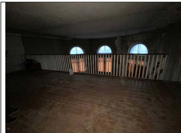
Фото № 19 – Внутреннее состояние помещения 21-Н
