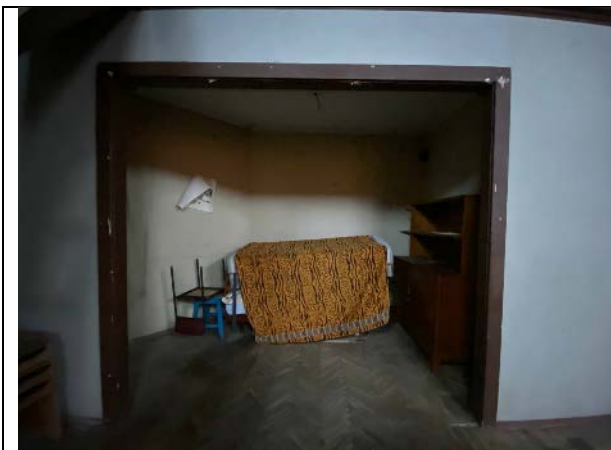
Фото № 13 – Внутреннее состояние помещения 21-Н
