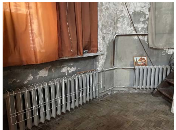
Фото № 20 – Внутреннее состояние помещения 21-Н
