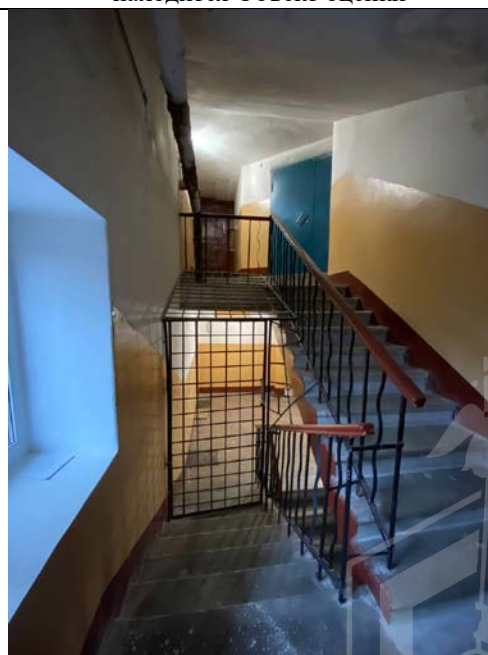
Фото № 6 – Проход к помещению 21-Н
