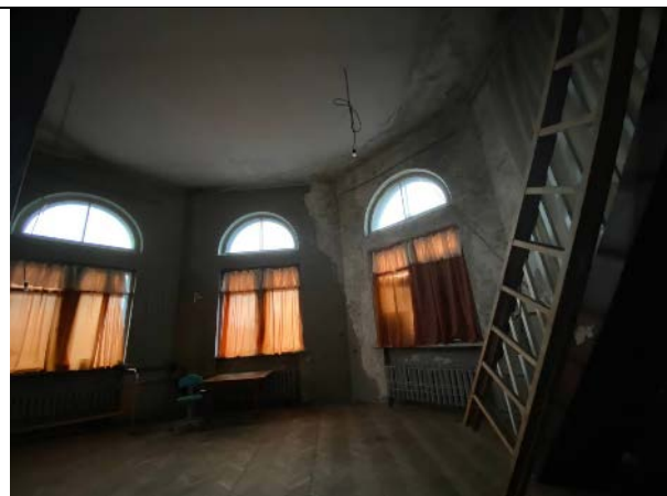
Фото № 14 – Внутреннее состояние помещения 21-Н
