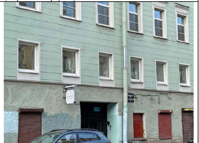
Фото 18. Ближайшее окружение Объекта оценки (Апраксин переулок)
