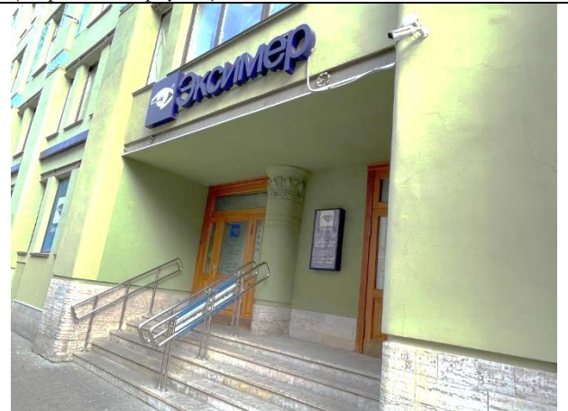
Фото 10. Ближайшее окружение Объекта оценки (Апраксин переулок)
