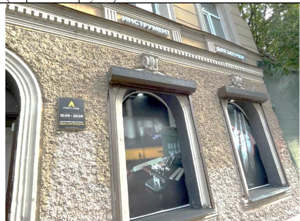
Фото 32. Ближайшее окружение Объекта оценки (Апраксин переулок)
