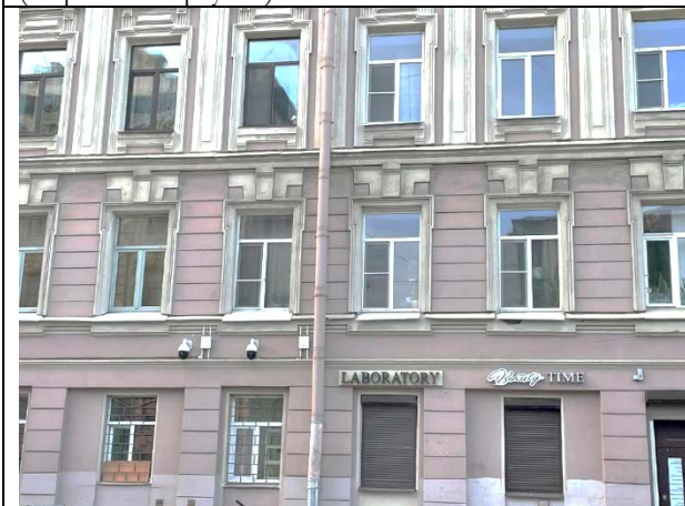
Фото 23. Ближайшее окружение Объекта оценки (Апраксин переулок)
