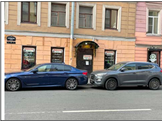
Фото 13. Ближайшее окружение Объекта оценки (Апраксин переулок)
