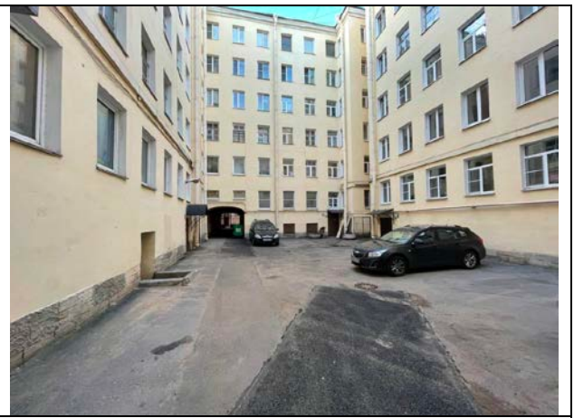
Фото 38. Внутри дворовая территория Объекта оценки
