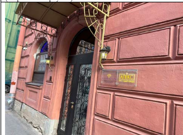
Фото 19. Ближайшее окружение Объекта оценки (Апраксин переулок)
