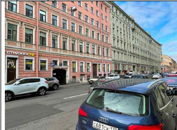
Фото 9. Ближайшее окружение Объекта оценки (Апраксин переулок)
