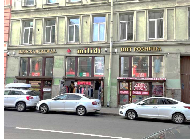
Фото 8. Ближайшее окружение Объекта оценки (Апраксин переулок)
