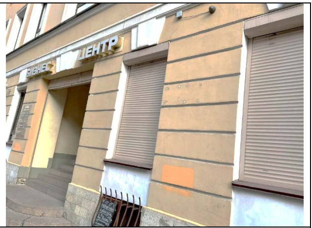
Фото 14. Ближайшее окружение Объекта оценки (Апраксин переулок)
