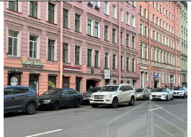
Фото 12. Ближайшее окружение Объекта оценки (Апраксин переулок)
