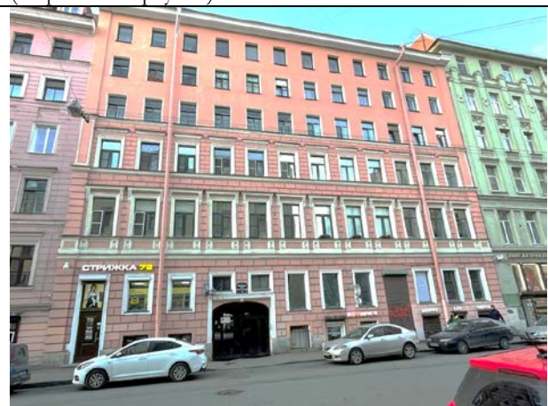
Фото 34. Вид здания Объекта оценки
