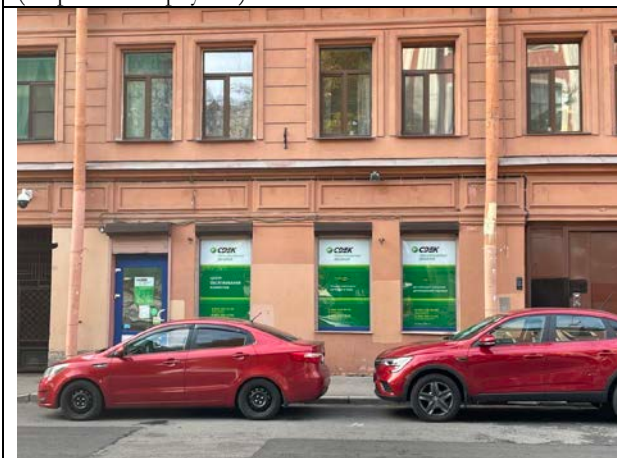
Фото 25. Ближайшее окружение Объекта оценки (Апраксин переулок)
