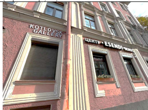
Фото 26. Ближайшее окружение Объекта оценки (Апраксин переулок)
