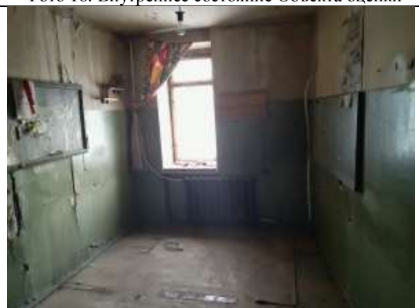
Фото 18. Внутреннее состояние Объекта оценки
