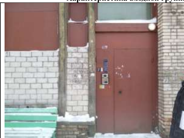
Фото 7. Доступ Объекта оценки – общий вход со двора
