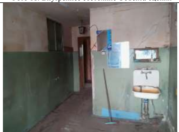
Фото 20. Внутреннее состояние Объекта оценки
