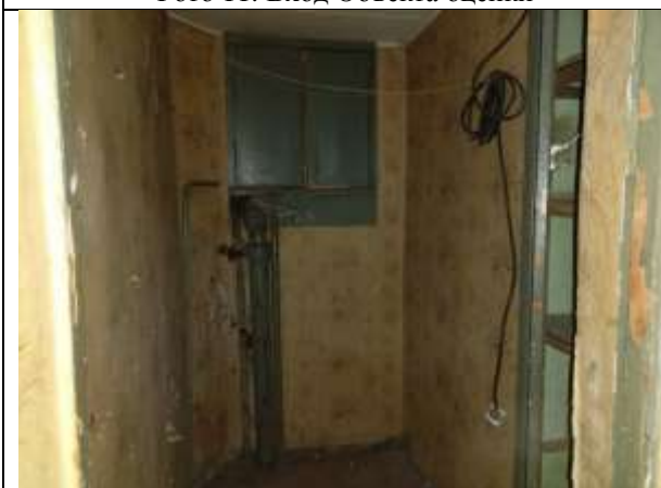
Фото 13. Внутреннее состояние Объекта оценки
