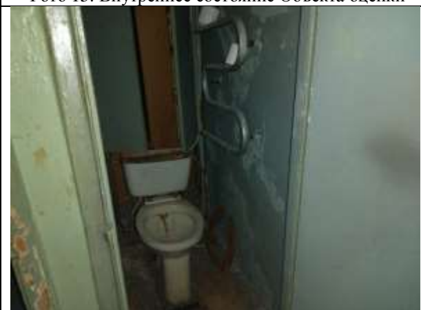
Фото 17. Внутреннее состояние Объекта оценки
