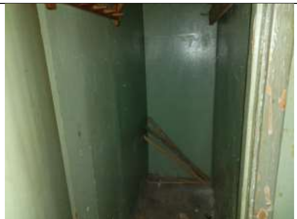
Фото 16. Внутреннее состояние Объекта оценки
