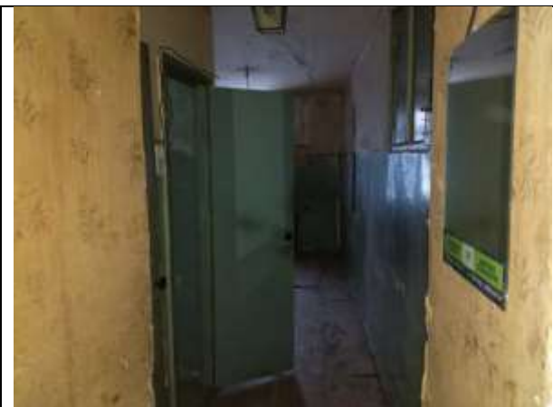
Фото 15. Внутреннее состояние Объекта оценки
