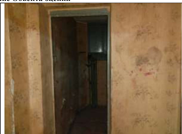
Фото 12. Внутреннее состояние Объекта оценки
