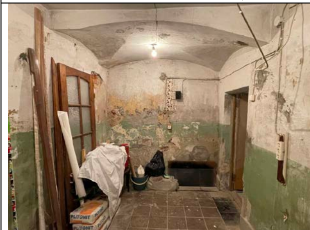
Фото 39. Типичное состояние Объекта оценки
