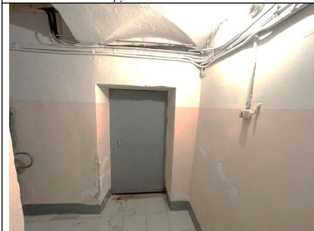
Фото 35. Типичное состояние Объекта оценки
