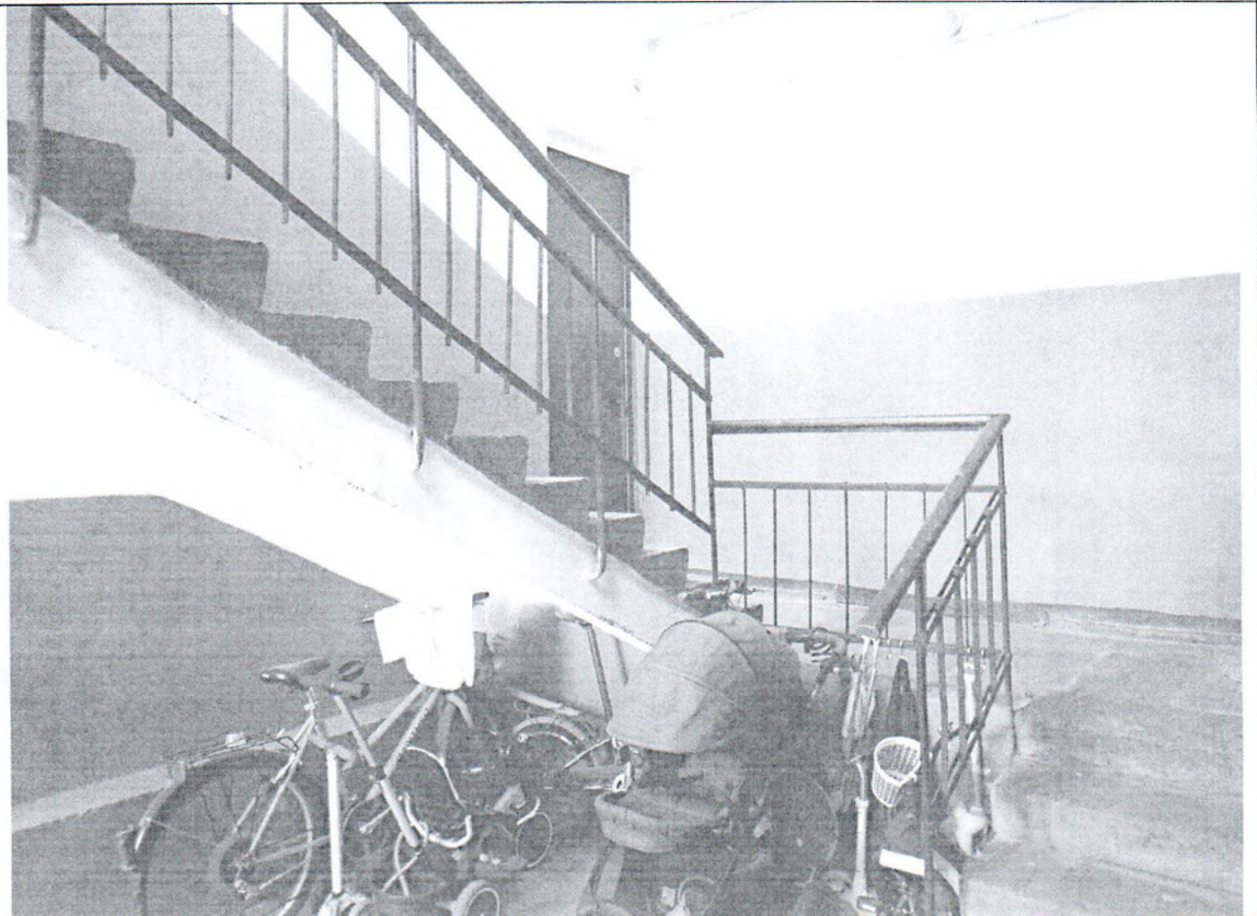
Описание: Общий вход в Объект
