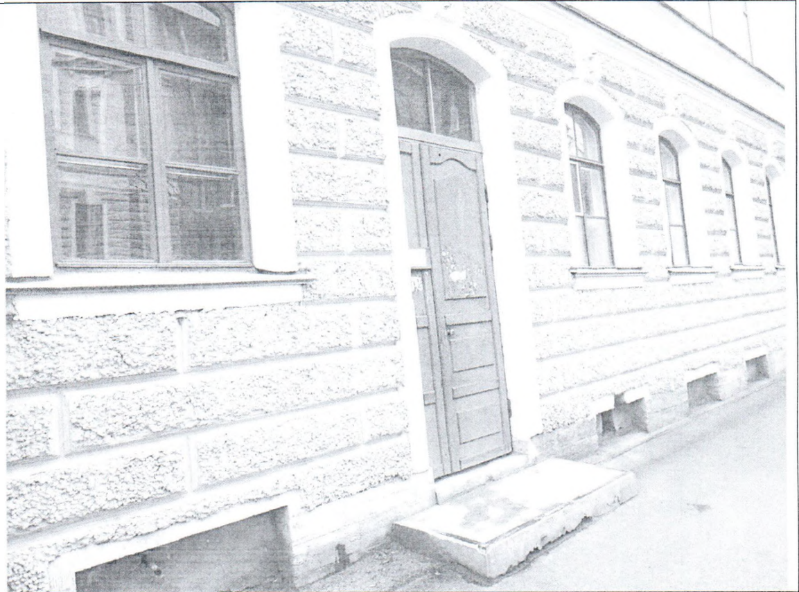
Описание: Общий вход в Объект
