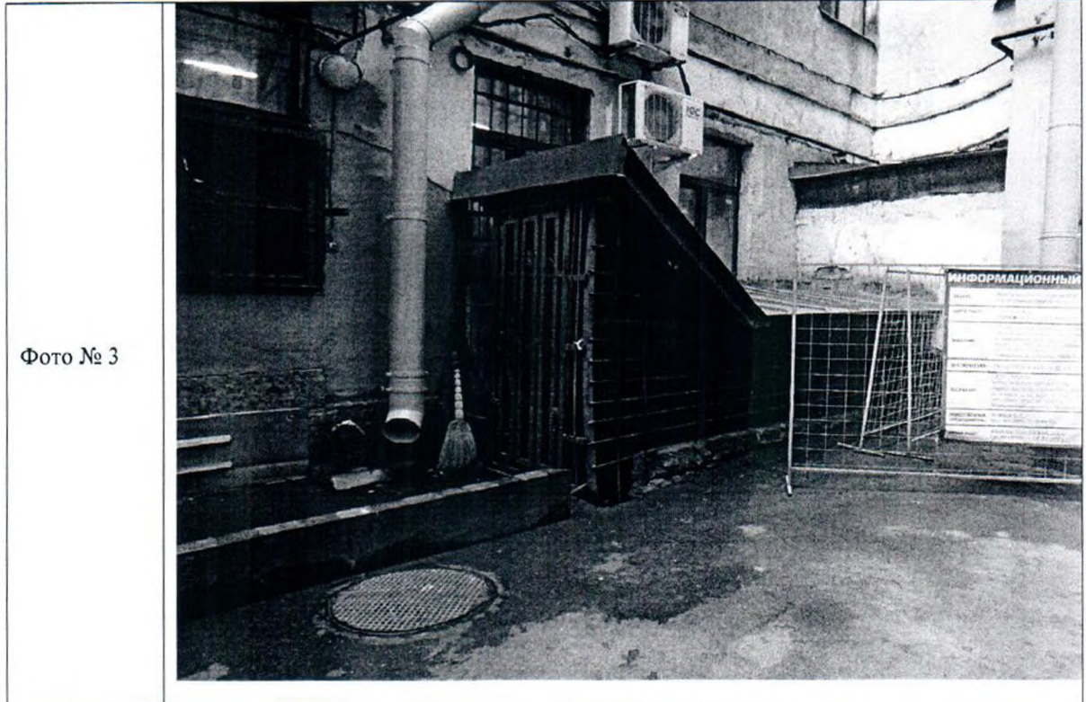
Описание: Вход в Объект
