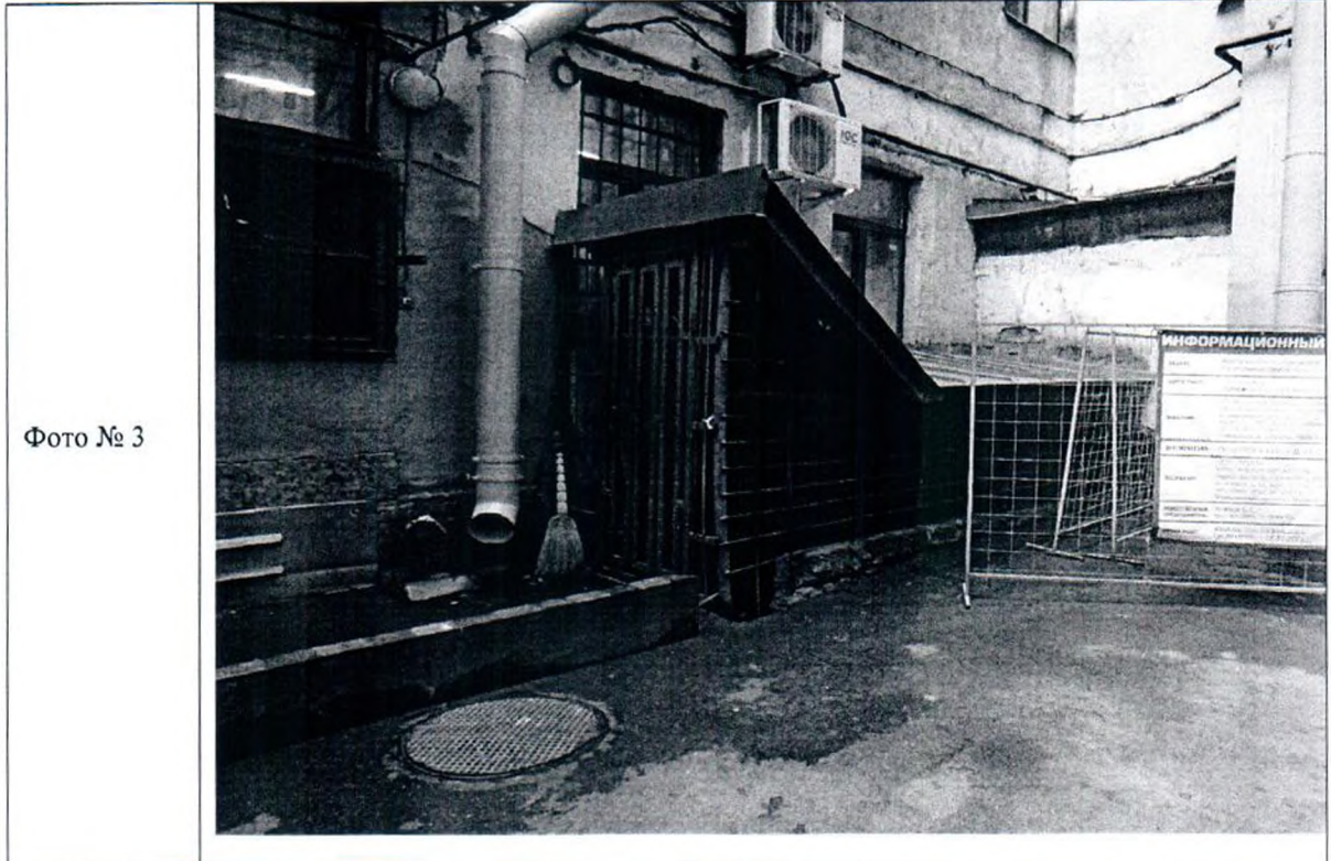
Описание: Вход в Объект
