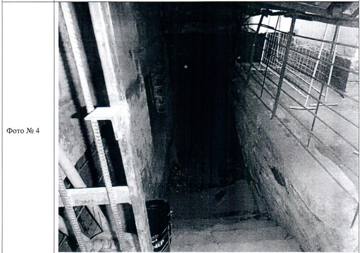
Описание: Вход в Объект
