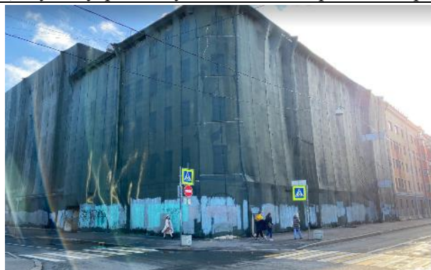
Фото №1 – Здание, входящее в Объект оценки
