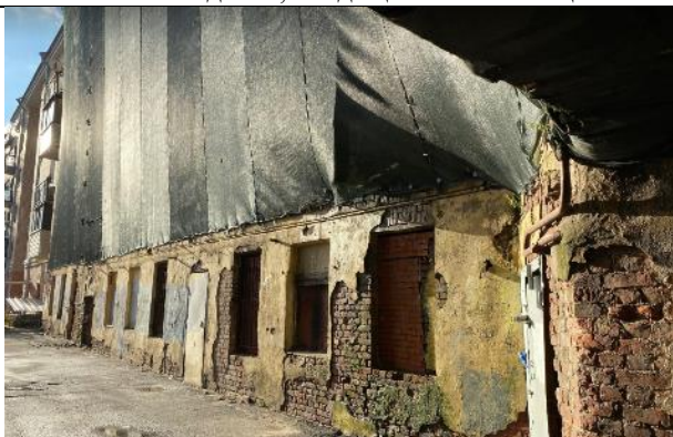
Фото №3 – Входы в здание со двора
