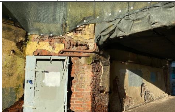
Фото №4 – Вход в здание со двора
