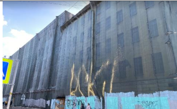
Фото №2 - Здание, входящее в Объект оценки
