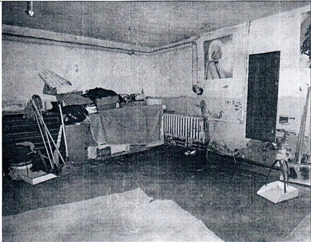
Описание: Общий вид Объекта
