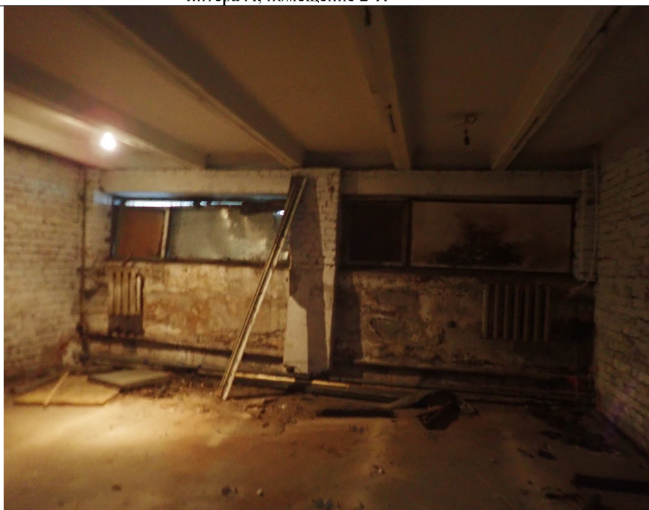
Описание: Вид внутри Объекта (ч.п. 2)
