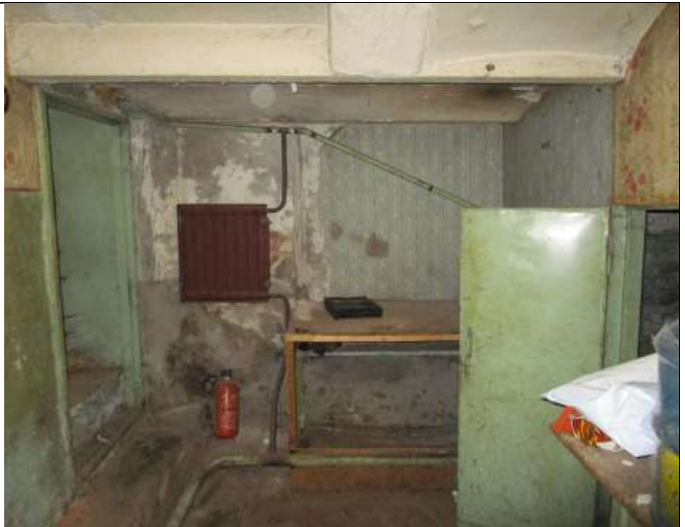
Описание: Вид внутри Объекта (ч.п. 2)
