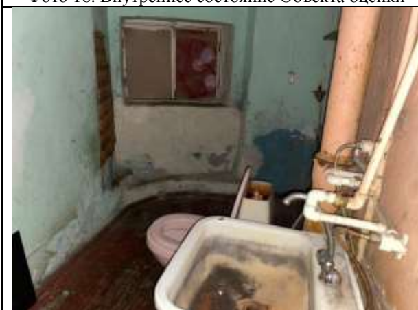
Фото 18. Внутреннее состояние Объекта оценки
