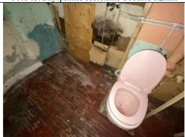
Фото 17. Внутреннее состояние Объекта оценки
