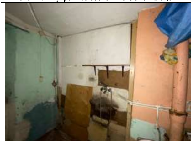
Фото 16. Внутреннее состояние Объекта оценки
