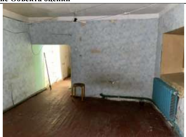
Фото 11. Внутреннее состояние Объекта оценки
