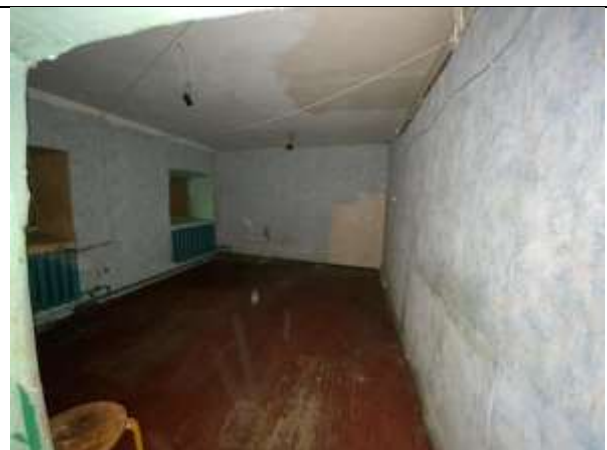
Фото 15. Внутреннее состояние Объекта оценки
