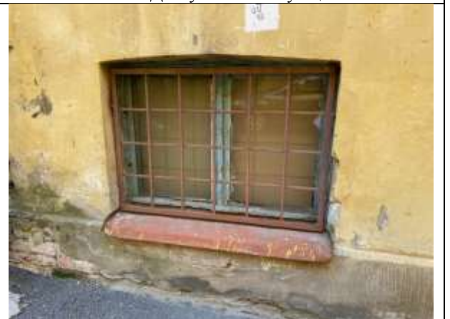
Фото 7. Отдельный вход со двора и окно Объекта
