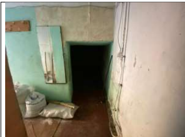
Фото 14. Внутреннее состояние Объекта оценки
