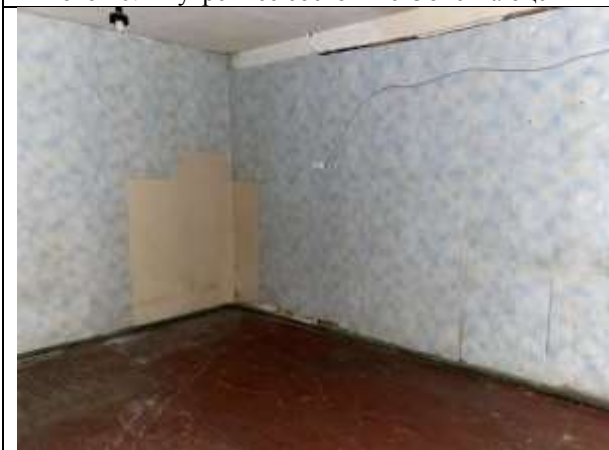
Фото 12. Внутреннее состояние Объекта оценки
