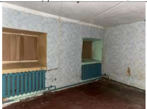
Фото 13. Внутреннее состояние Объекта оценки
