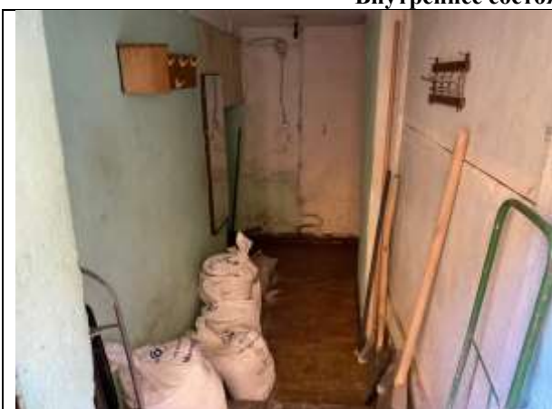
Фото 10. Внутреннее состояние Объекта оценки
