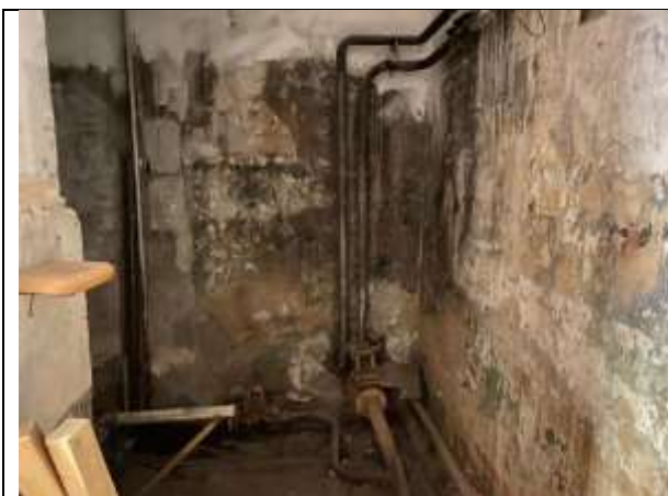
Фото 22. Внутреннее состояние Объекта оценки
