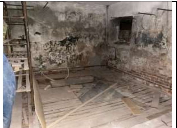
Фото 15. Внутреннее состояние Объекта оценки
