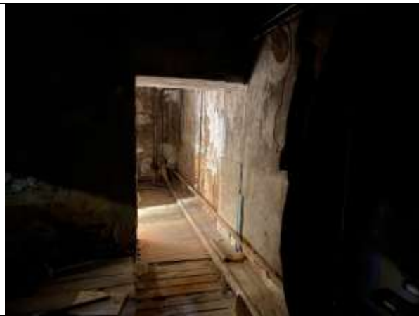
Фото 14. Внутреннее состояние Объекта оценки
