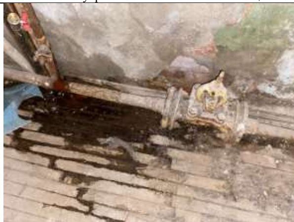
Фото 18. Внутреннее состояние Объекта оценки
