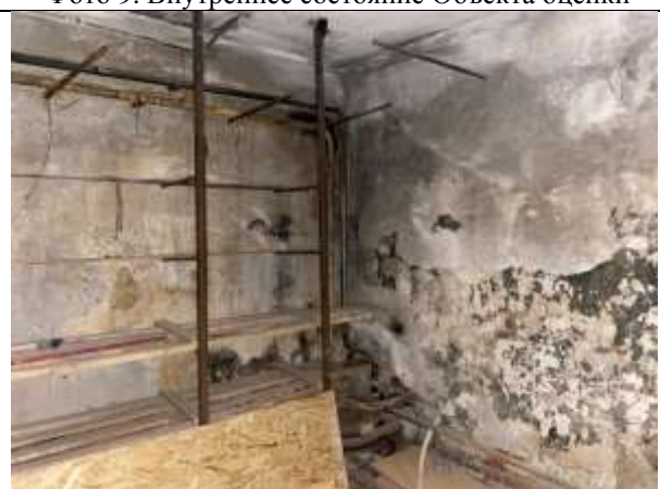
Фото 11. Внутреннее состояние Объекта оценки
