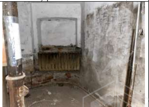
Фото 21. Внутреннее состояние Объекта оценки
