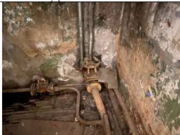
Фото 20. Внутреннее состояние Объекта оценки (транзитные трубы)
