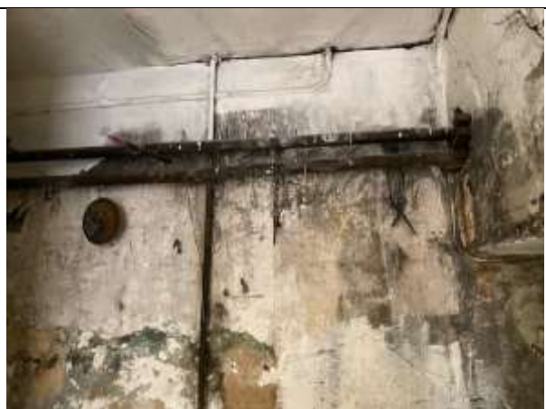
Фото 23. Внутреннее состояние Объекта оценки
