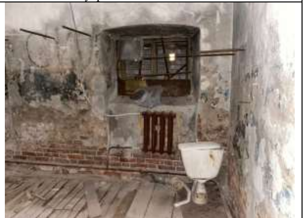
Фото 17. Внутреннее состояние Объекта оценки
