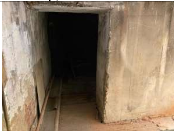
Фото 16. Внутреннее состояние Объекта оценки
