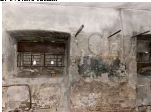
Фото 9. Внутреннее состояние Объекта оценки
