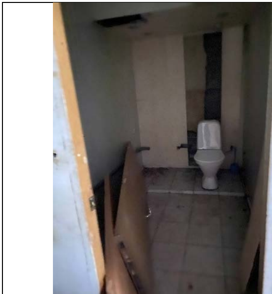
Фото № 7 - Внутреннее состояние
