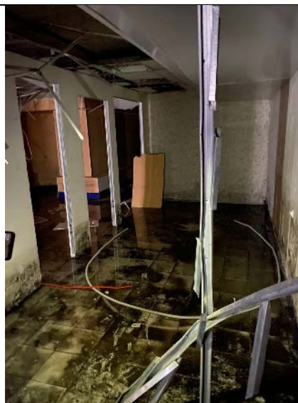
Фото № 4 – Внутреннее состояние
