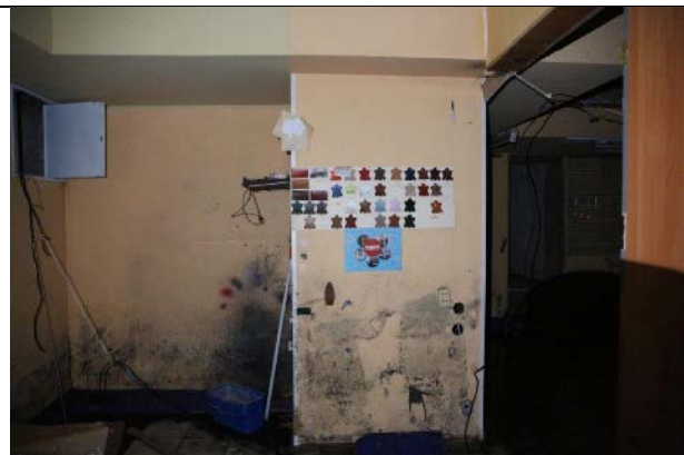
Фото № 17 - Внутреннее состояние
