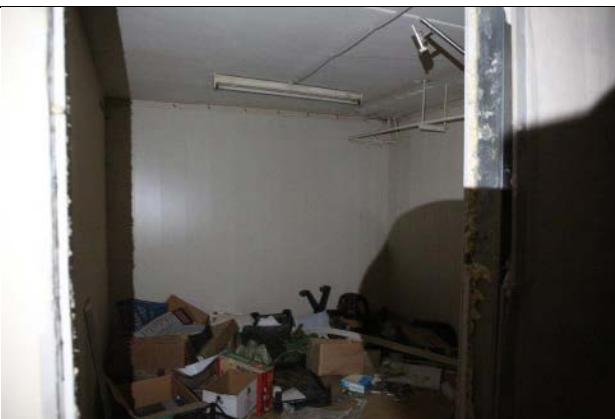
Фото № 19 - Внутреннее состояние
