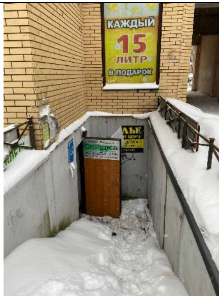
Фото № 2 – Вход в помещение
