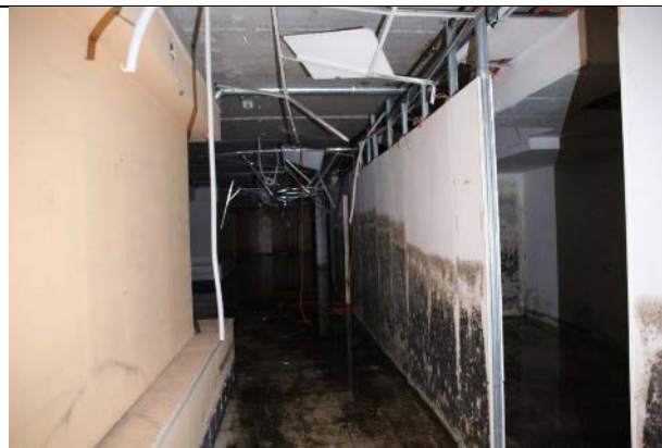
Фото № 10 - Внутреннее состояние
