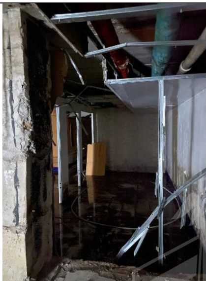
Фото № 6 - Внутреннее состояние
