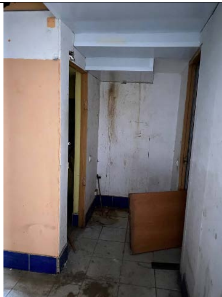
Фото № 8 - Внутреннее состояние
