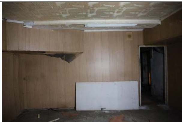
Фото № 25 - Внутреннее состояние
