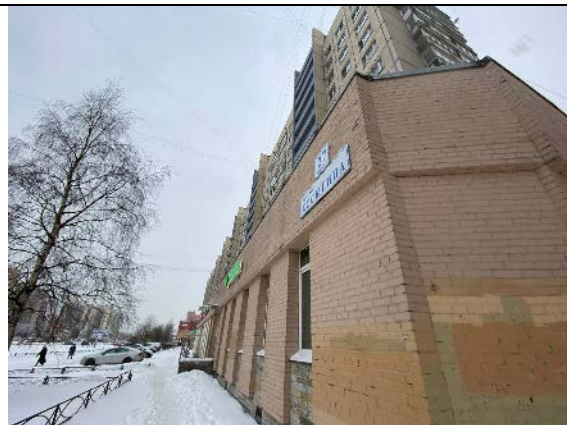
Фото № 28 – Фасад здания
