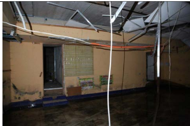
Фото № 16 - Внутреннее состояние
