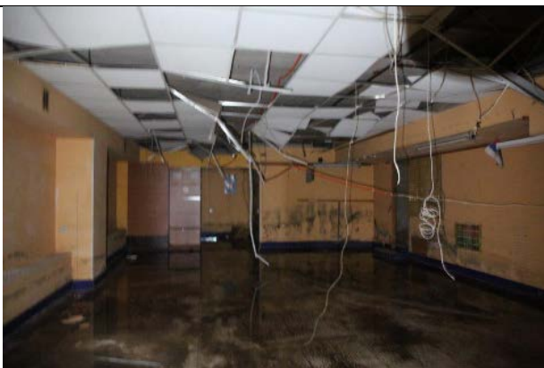
Фото № 13 - Внутреннее состояние
