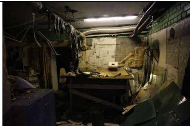
Фото № 24 - Внутреннее состояние
