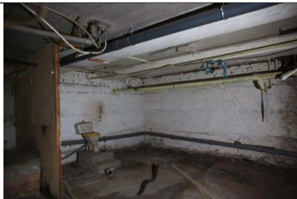
Фото № 26 - Внутреннее состояние
