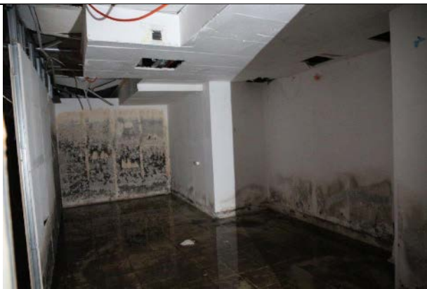
Фото № 9 - Внутреннее состояние
