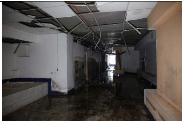
Фото № 15 - Внутреннее состояние
