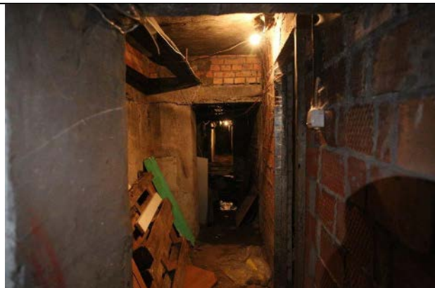
Фото № 23 - Внутреннее состояние
