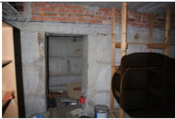
Фото № 20 - Внутреннее состояние
