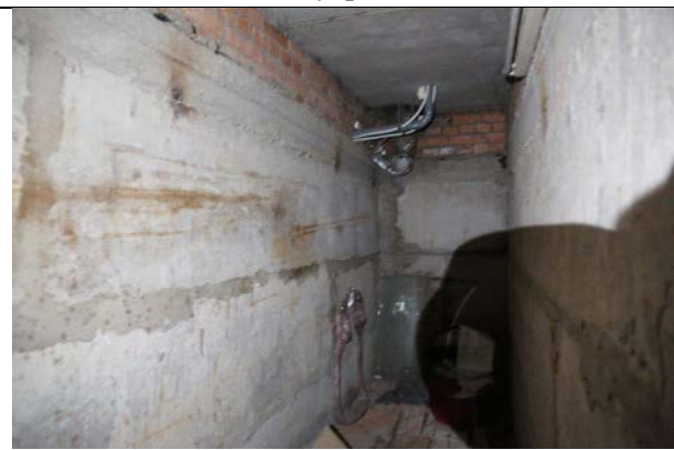
Фото № 21 - Внутреннее состояние
