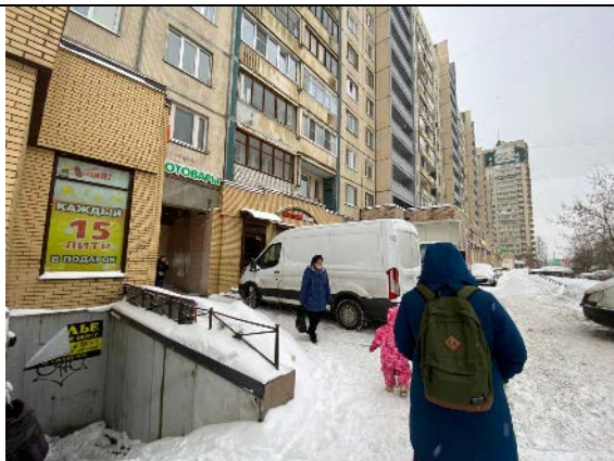
Фото № 27 – Фасад здания
