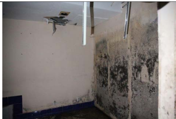
Фото № 12 - Внутреннее состояние
