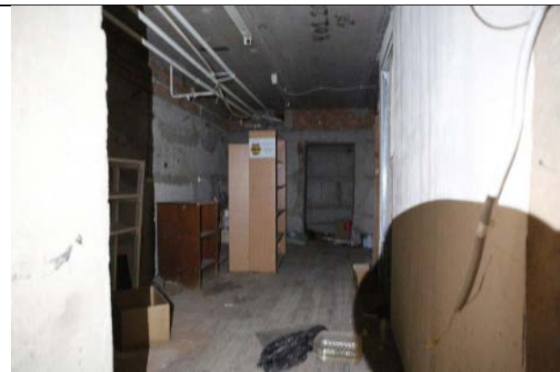
Фото № 18 - Внутреннее состояние
