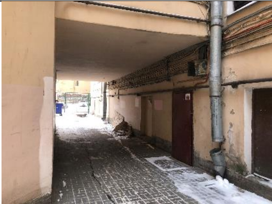
Фото № 7 – Отдельный вход в помещение 4-Н
