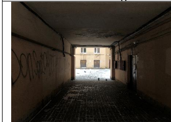
Фото № 5 – Проход к помещению 4-Н через арку
