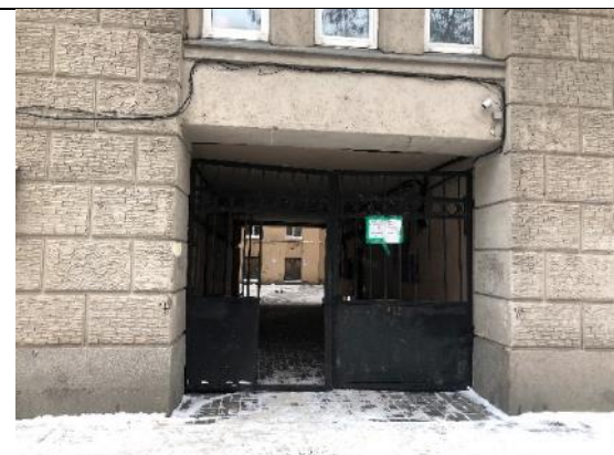
Фото № 4 – Проход к помещению 4-Н через арку
