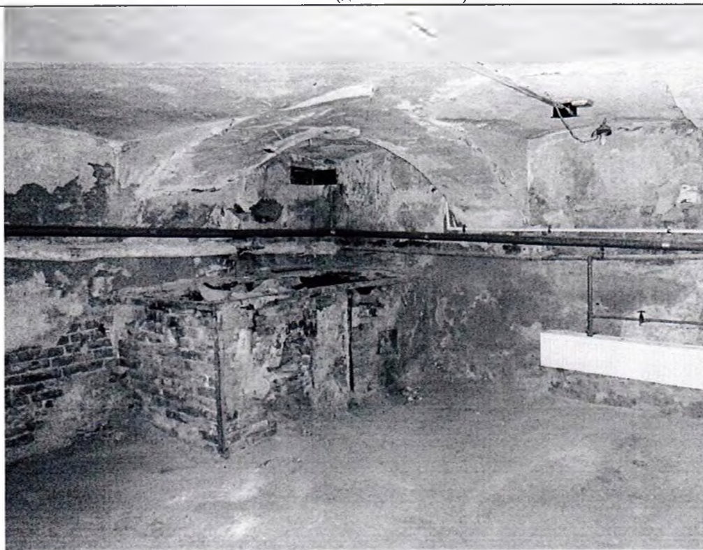
Описание: Вход в Объект
