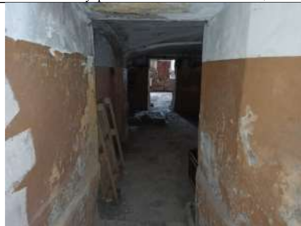
Фото 27. Внутреннее состояние Объекта оценки
