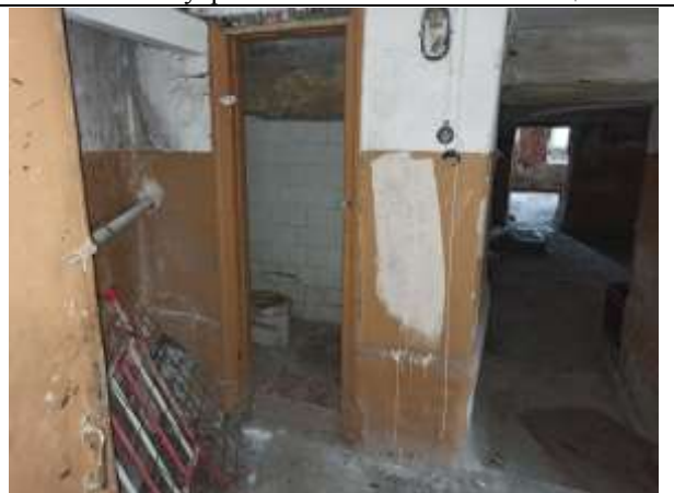
Фото 28. Внутреннее состояние Объекта оценки
