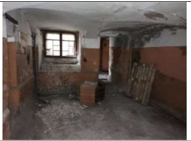
Фото 24. Внутреннее состояние Объекта оценки
