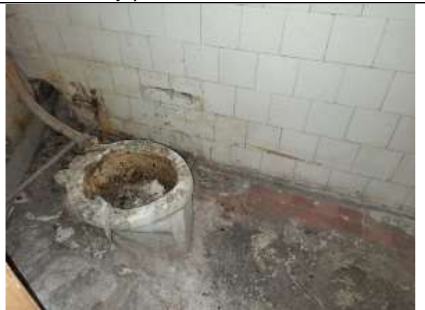
Фото 26. Внутреннее состояние Объекта оценки
