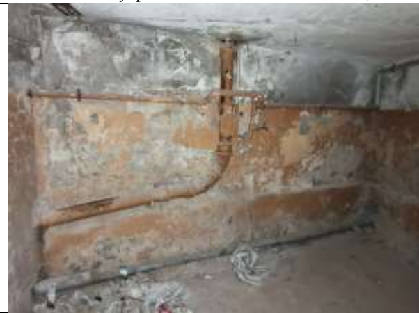
Фото 29. Внутреннее состояние Объекта оценки
