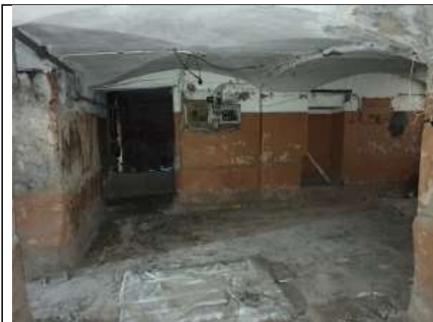
Фото 15. Внутреннее состояние Объекта оценки
