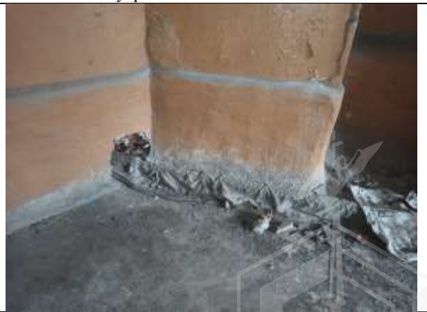
Фото 30. Внутреннее состояние Объекта оценки
