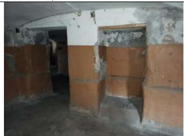
Фото 12. Внутреннее состояние Объекта оценки
