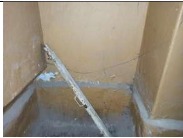
Фото 23. Внутреннее состояние Объекта оценки
