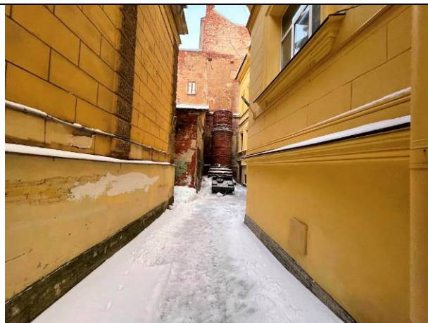
Фото 14. Внутри дворовая территория Объекта оценки
