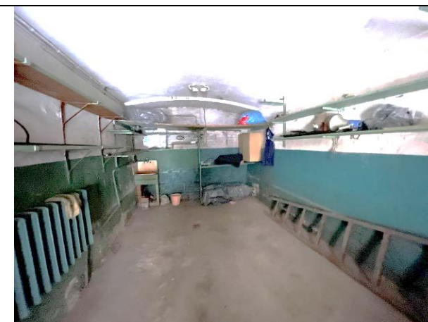
Фото 17. Типичное состояние Объекта оценки (помещение 11-Н)
