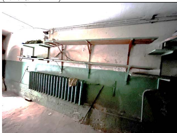
Фото 18. Типичное состояние Объекта оценки (помещение 11-Н)
