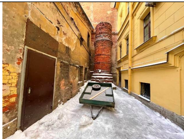
Фото 13. Внутри дворовая территория Объекта оценки
