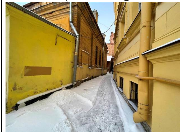
Фото 11. Внутри дворовая территория Объекта оценки
