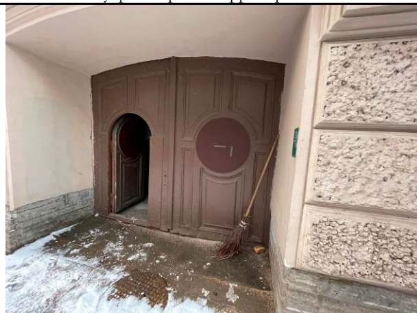
Фото 15. Вход в Объект оценки (помещение 11-Н)
