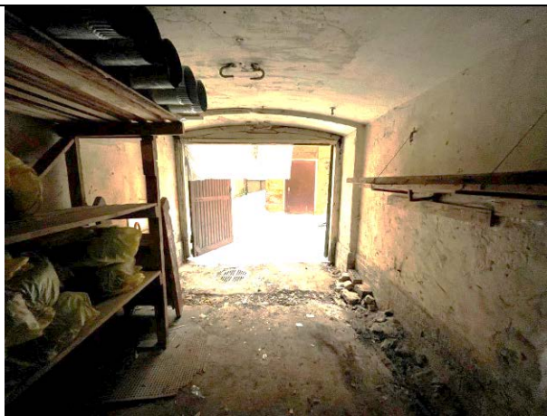
Фото 21. Типичное состояние Объекта оценки (помещение 12-Н)
