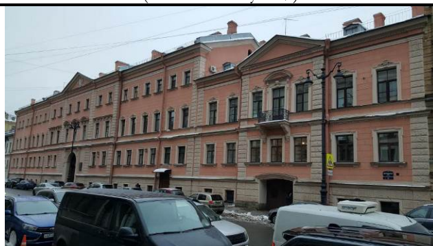
Фото 8. Вид здания расположения Объекта оценки
