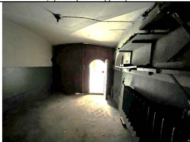
Фото 16. Типичное состояние Объекта оценки (помещение 11-Н)
