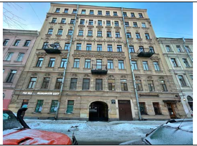
Фото 16. Вид расположения здания Объекта оценки
