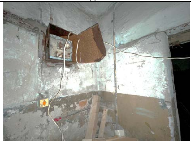
Фото 26. Типичное состояние Объекта оценки
