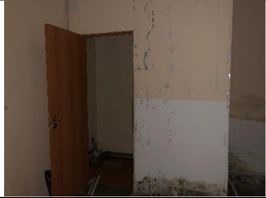
Фото № 10 – Внутреннее состояние
