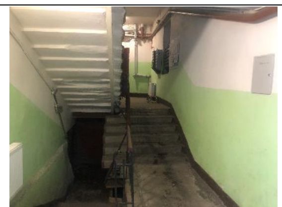
Фото № 4 – Проход к помещению 7-Н
