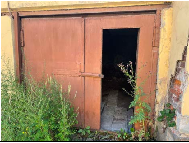
Фото 25. Вход в здание Объекта оценки
