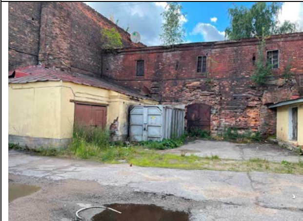
Фото 23. Вид здания объекта оценки
