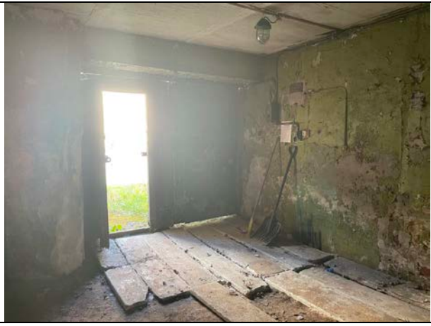
Фото 26. Вход в здание Объекта оценки
