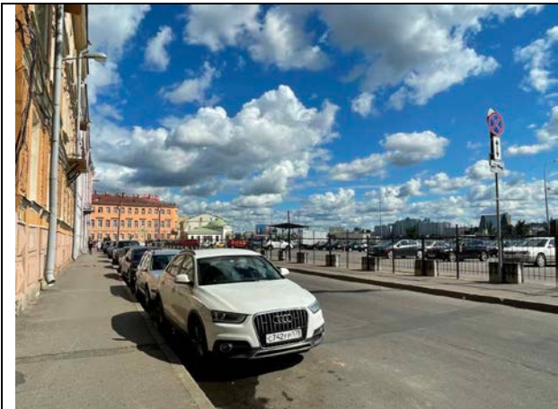
Фото 1. Ближайшее окружение Объекта оценки (Синопская набережная)
