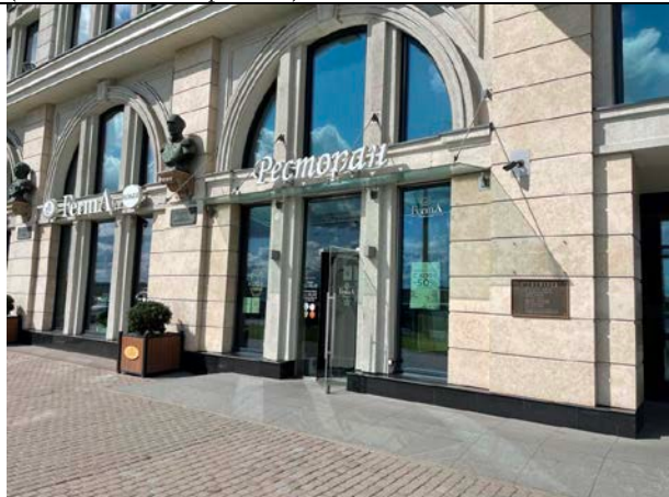
Фото 5. Ближайшее окружение Объекта оценки (Синопская набережная)
