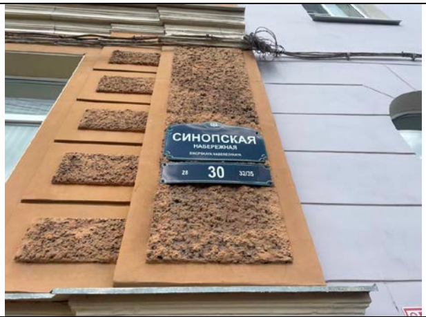
Фото 10. Адрес Объекта оценки
