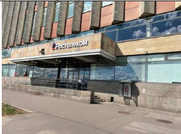
Фото 7. Ближайшее окружение Объекта оценки (Синопская набережная)
