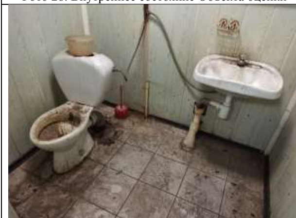
Фото 30. Внутреннее состояние Объекта оценки
