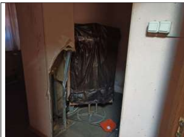
Фото 28. Внутреннее состояние Объекта оценки
