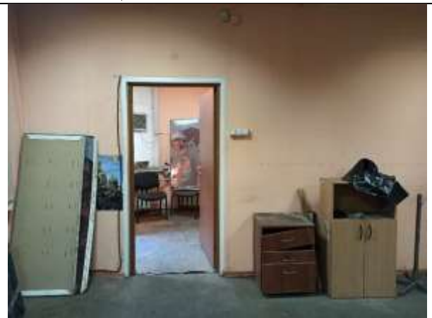
Фото 17. Внутреннее состояние Объекта оценки
