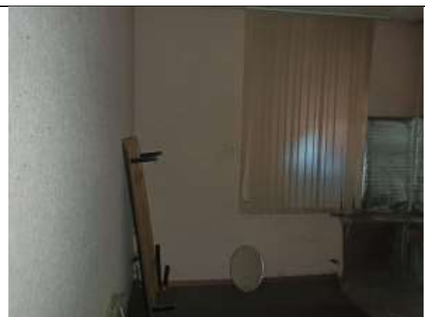
Фото 29. Внутреннее состояние Объекта оценки
