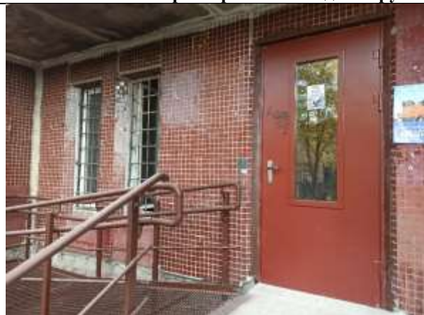
Фото 5. Общий вход со двора и окна Объекта
