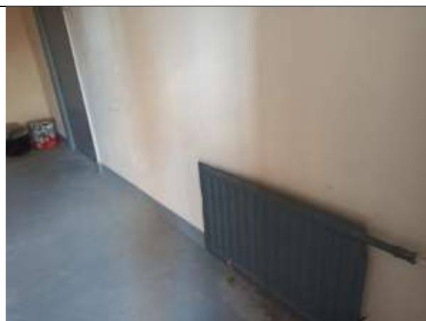
Фото 12. Внутреннее состояние Объекта оценки
