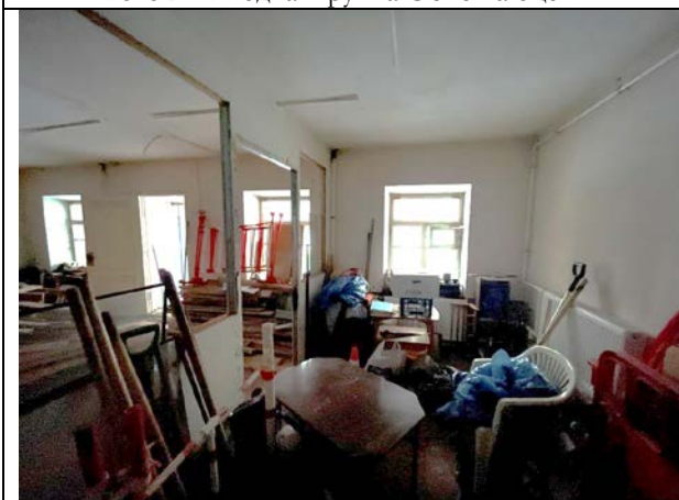
Фото 23. Типичное состояние Объекта оценки
