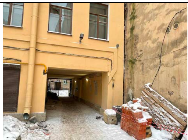
Фото 12. Проход через арку к Объекту оценки
