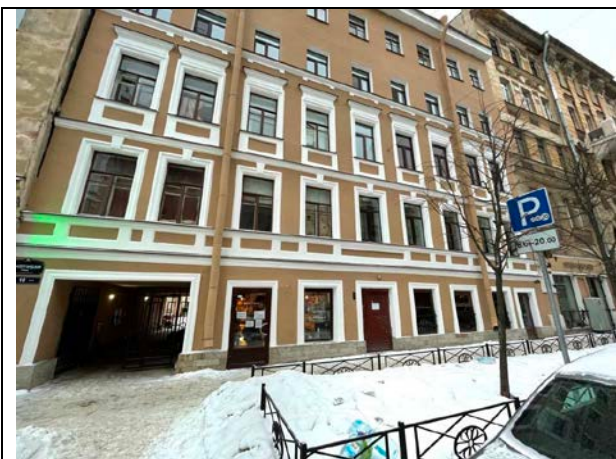
Фото 11. Вид здания расположения Объекта оценки
