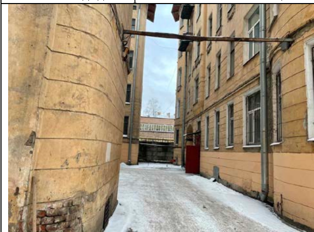
Фото 13. Внутри дворовая территория Объекта оценки
