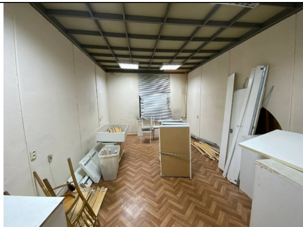
Фото № 8 – Внутреннее состояние помещения
