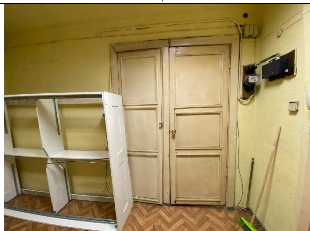
Фото № 10 – Внутреннее состояние помещения
