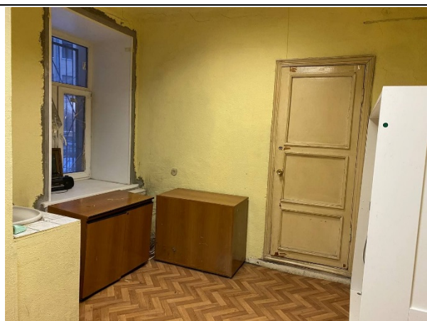
Фото № 9 – Внутреннее состояние помещения
