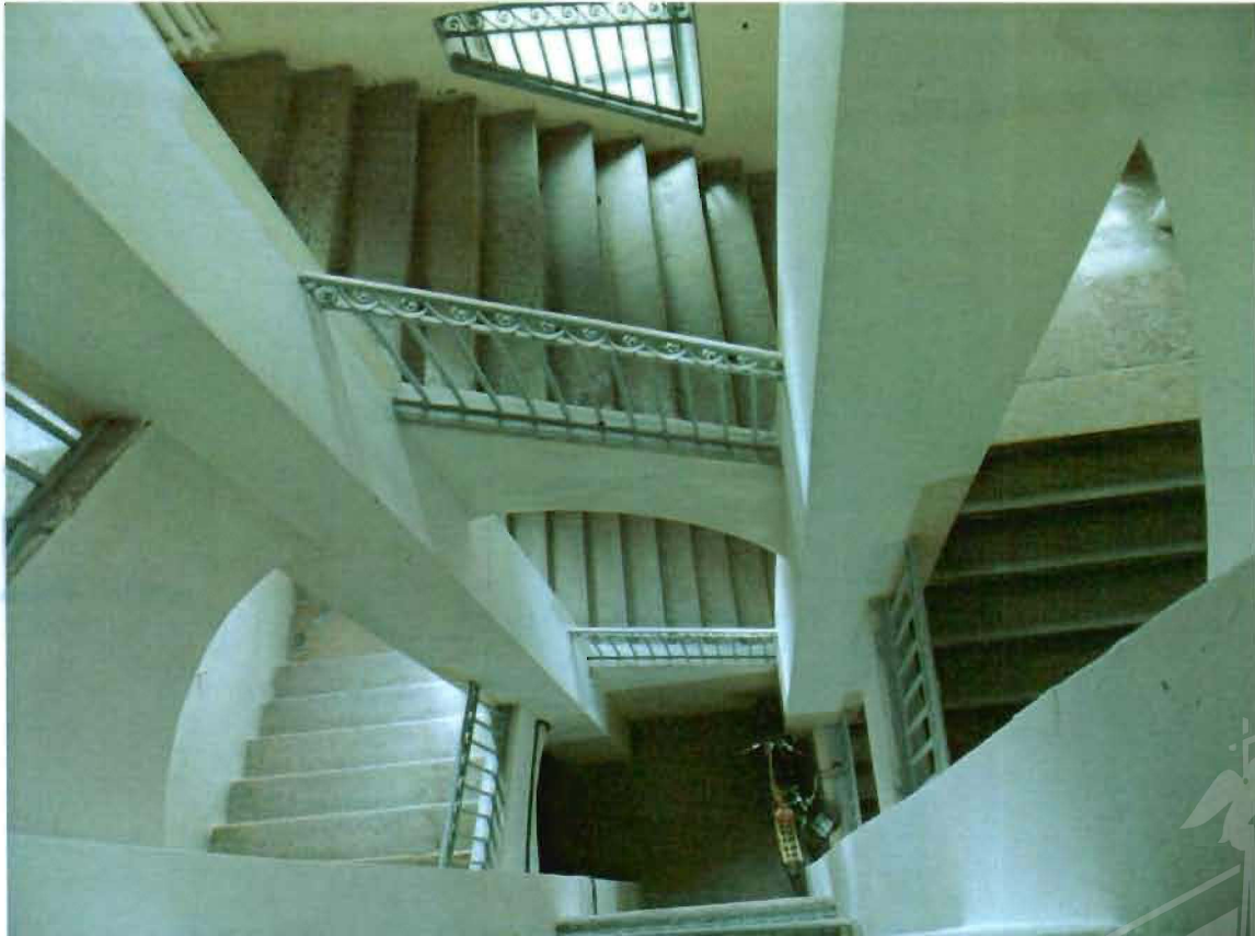
8. Лестница в корпусе по Миллионной улице.
