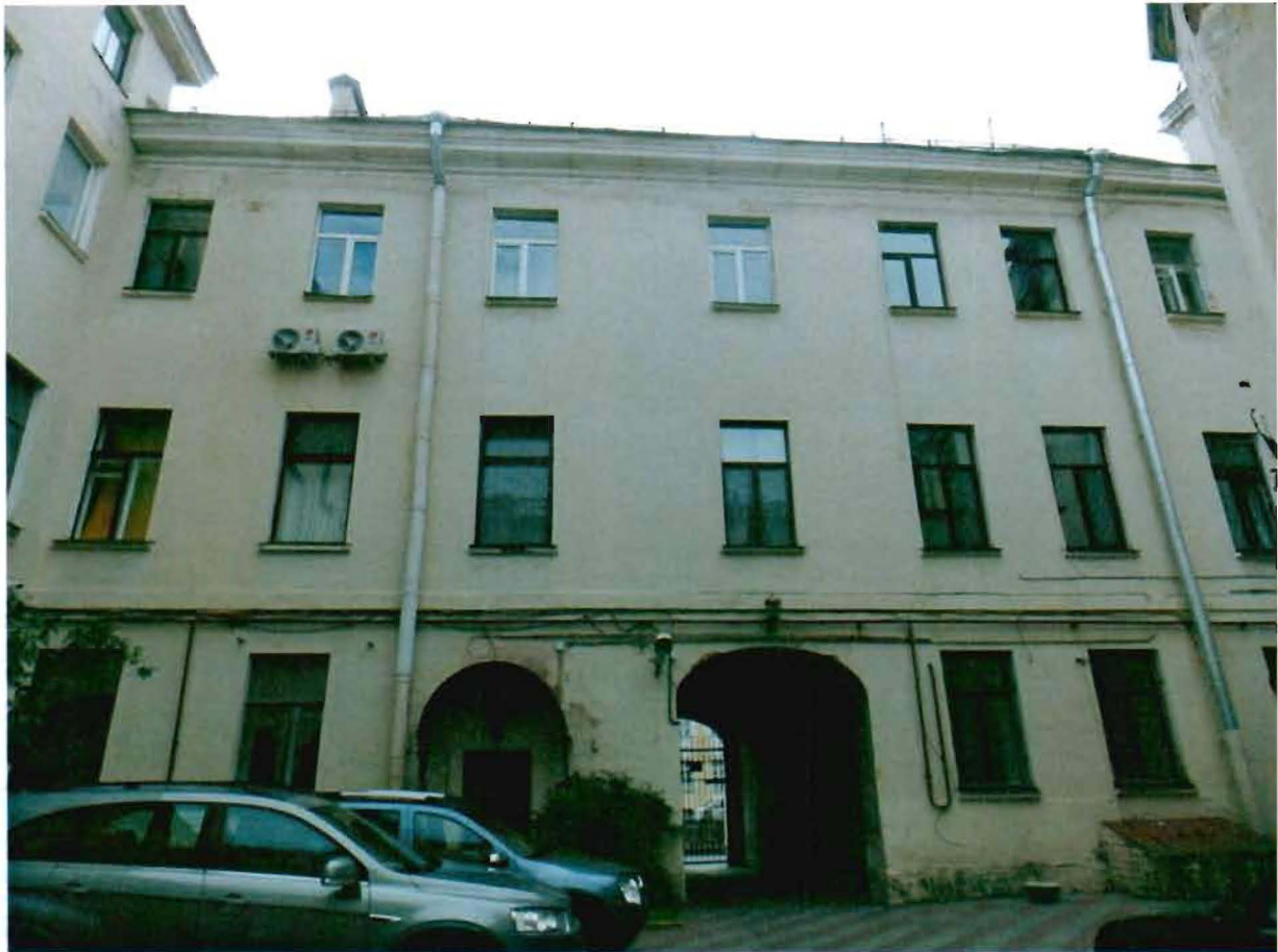
5. Дворовый фасад корпуса по набережной реки Мойки.
