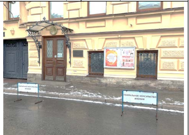
Фото 8. Ближайшее окружение Объекта оценки (наб.реки Мойки)
