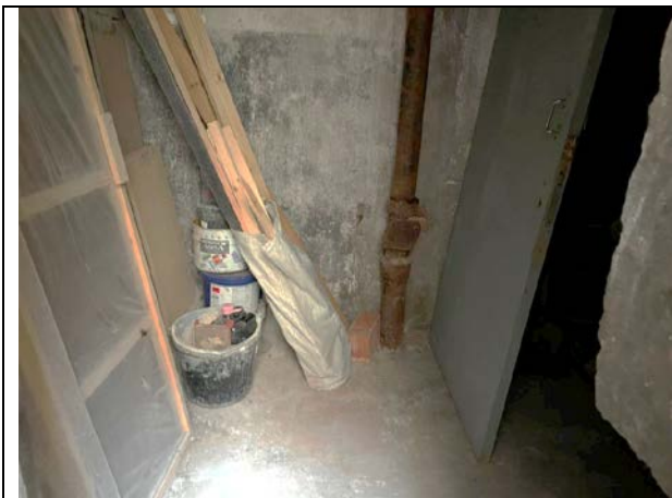
Фото 21. Типичное состояние Объекта оценки
