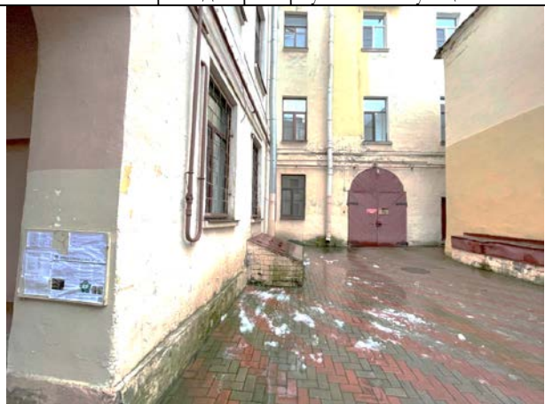
Фото 16. Внутри дворовая территория Объекта оценки
