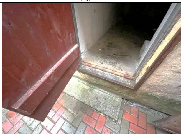
Фото 18. Вход в Объект оценки
