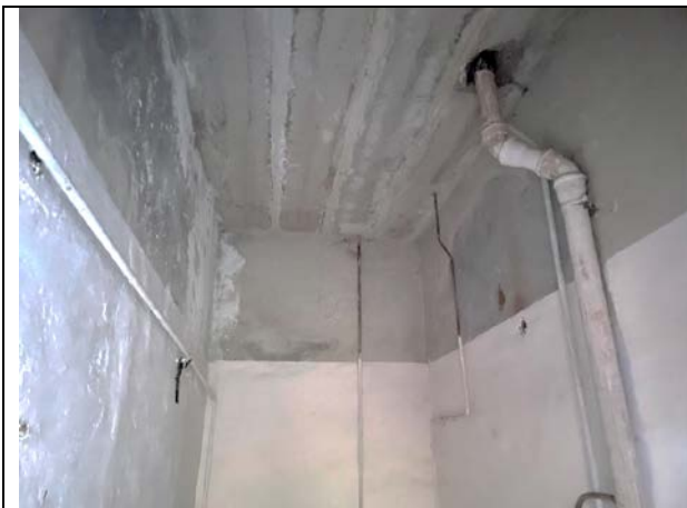
Фото 21. Типичное состояние Объекта оценки
