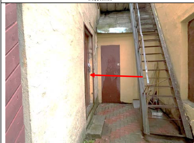
Фото 17. Вход в Объект оценки
