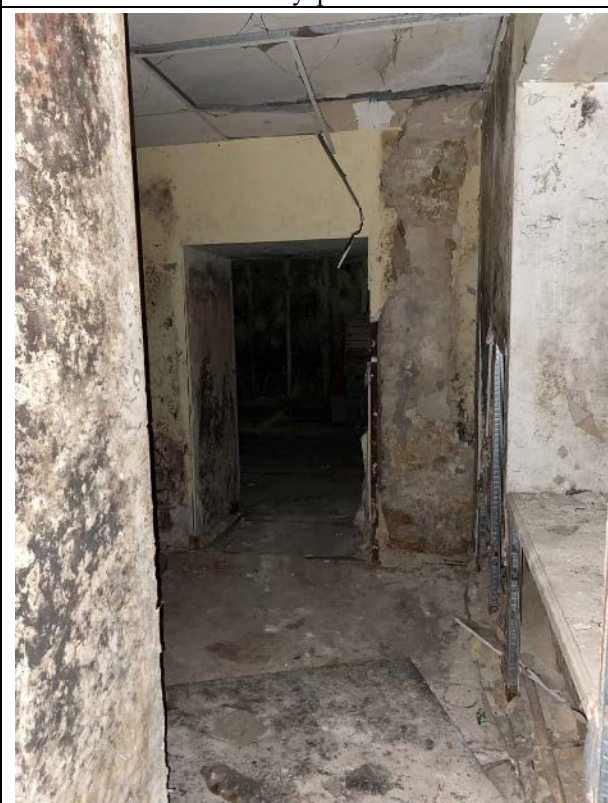
Фото № 13 – Внутреннее состояние
