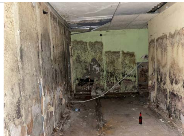
Фото № 16 – Внутреннее состояние
