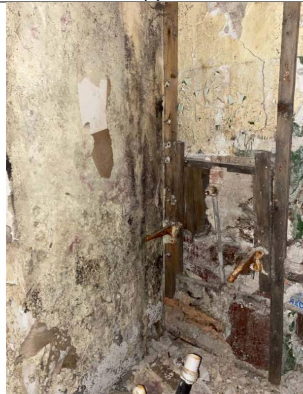
Фото № 18 – Внутреннее состояние
