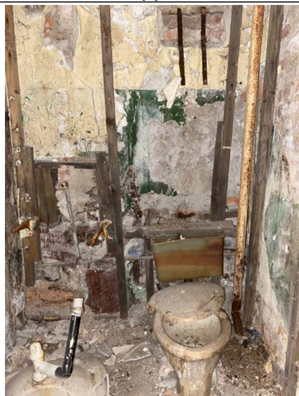
Фото № 17 – Внутреннее состояние
