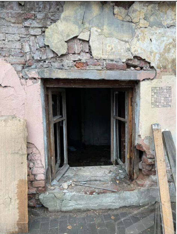
Фото № 6 – Оконный проем
