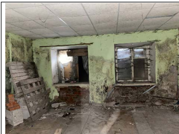
Фото № 15 – Внутреннее состояние
