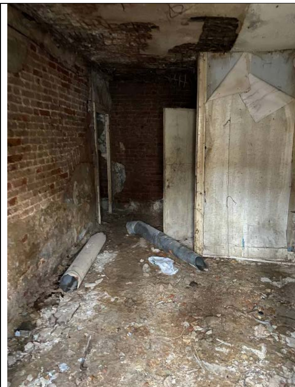
Фото № 11 – Внутреннее состояние
