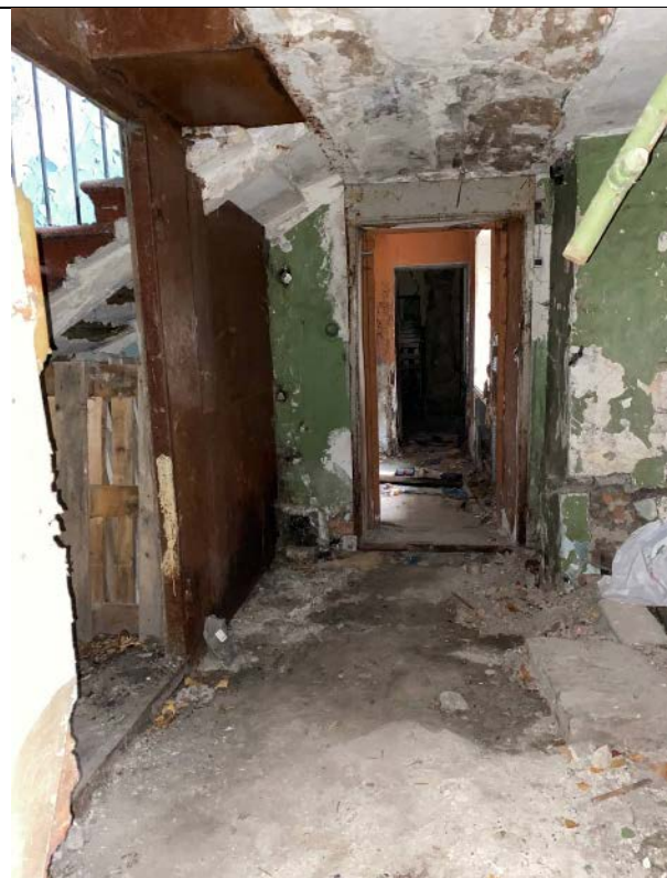
Фото № 8 – Внутреннее состояние
