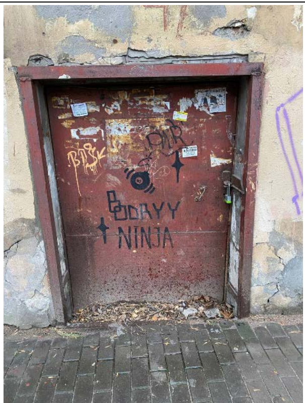
Фото № 5 – Общий вход со двора
