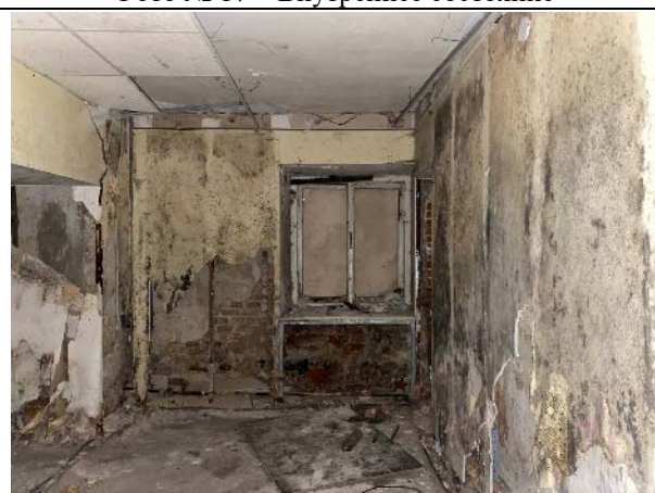
Фото № 19 – Внутреннее состояние
