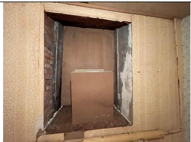
Фото 48. Типичное состояние Объекта оценки
