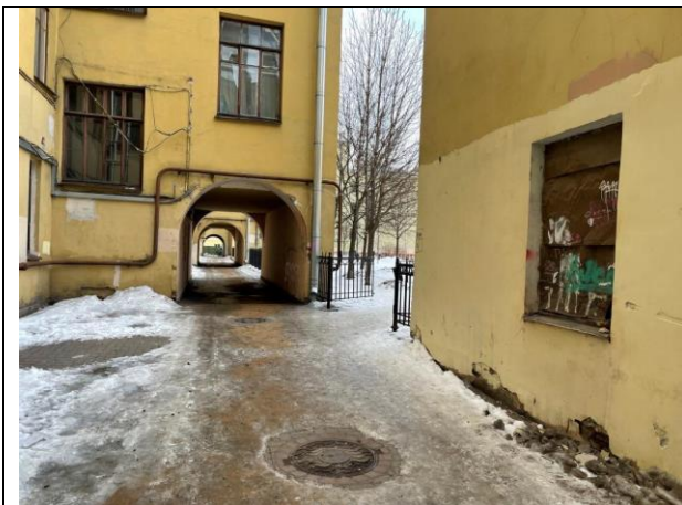
Фото 39. Внутри дворовая территория Объекта оценки
