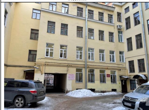
Фото 41. Внутри дворовая территория Объекта оценки
