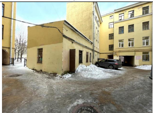
Фото 44. Входная и оконная группа Объекта оценки
