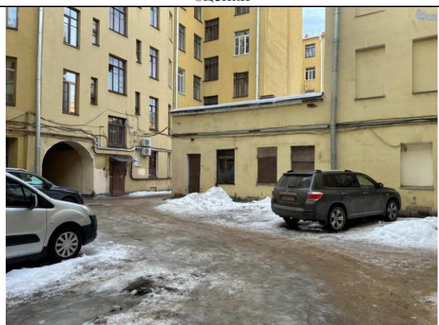
Фото 42. Внутри дворовая территория Объекта оценки
