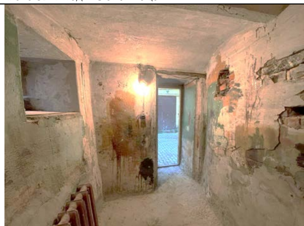
Фото 34. Типичное состояние Объекта оценки
