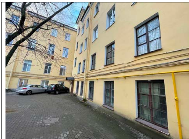
Фото 29. Внутри дворовая территория Объекта оценки
