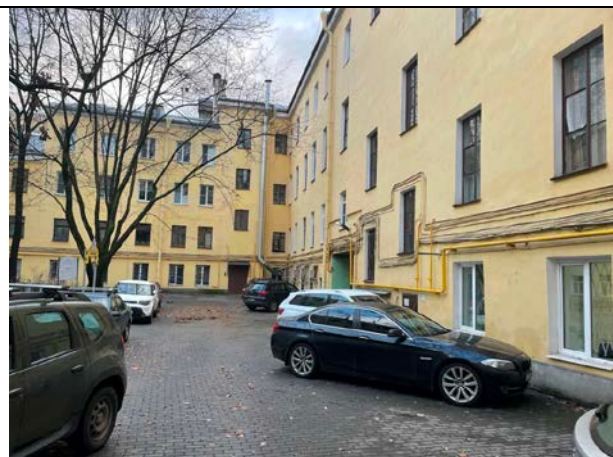
Фото 30. Внутри дворовая территория Объекта оценки
