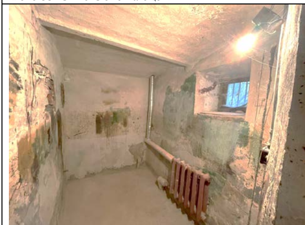
Фото 35. Типичное состояние Объекта оценки
