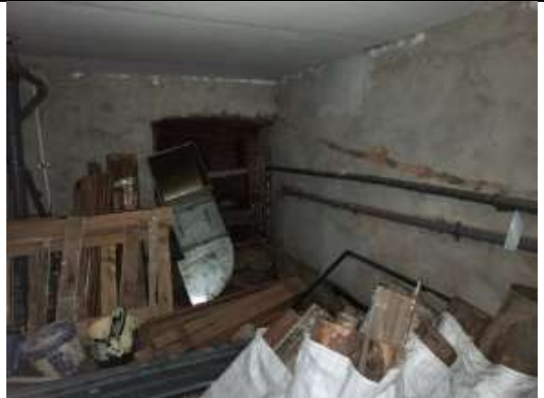
Фото 30. Внутреннее состояние Объекта оценки
