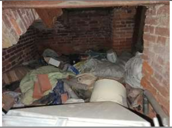
Фото 28. Внутреннее состояние Объекта оценки
