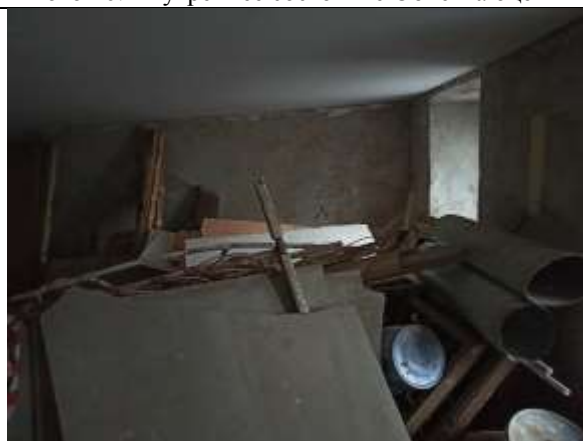
Фото 22. Внутреннее состояние Объекта оценки
