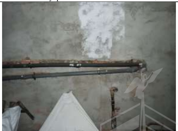
Фото 34. Внутреннее состояние Объекта оценки
