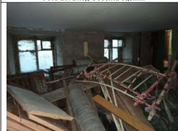
Фото 23. Внутреннее состояние Объекта оценки
