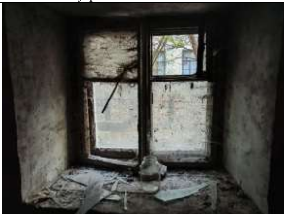
Фото 33. Внутреннее состояние Объекта оценки
