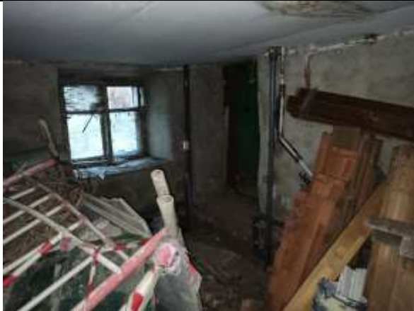
Фото 29. Внутреннее состояние Объекта оценки
