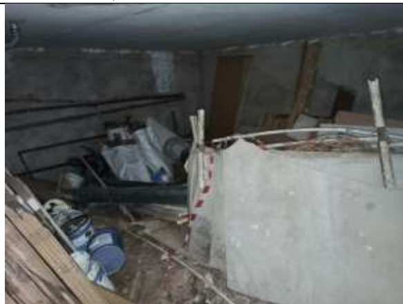
Фото 20. Внутреннее состояние Объекта оценки
