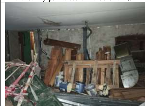
Фото 25. Внутреннее состояние Объекта оценки
