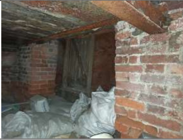
Фото 27. Внутреннее состояние Объекта оценки
