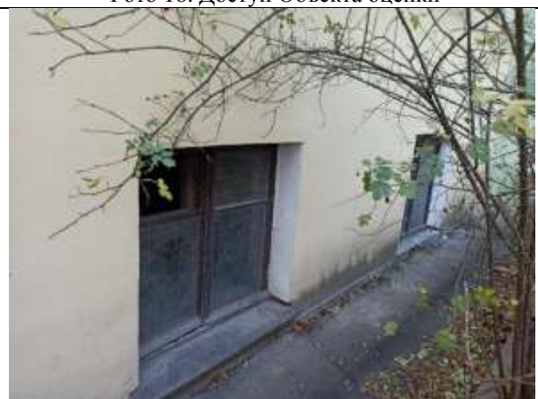
Фото 18. Оконные проемы Объекта оценки
