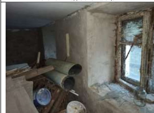
Фото 21. Вход Объекта оценки
