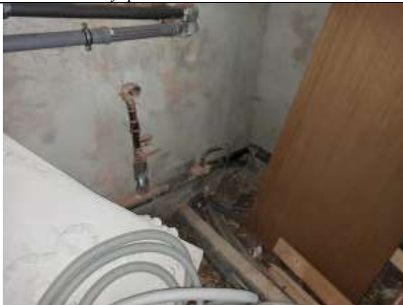
Фото 31. Внутреннее состояние Объекта оценки
