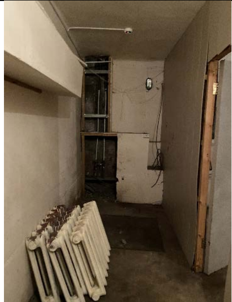
Фото № 22 – Внутреннее состояние помещения 4-Н
