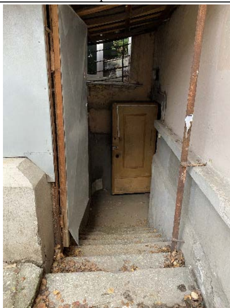
Фото № 5 – Вход в помещение 4-Н
