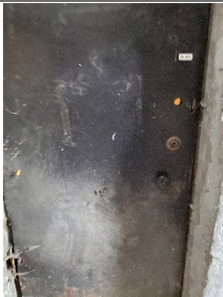
Фото № 7 – Вход в помещение 4-Н
