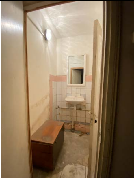
Фото № 13 – Внутреннее состояние помещения 4-Н
