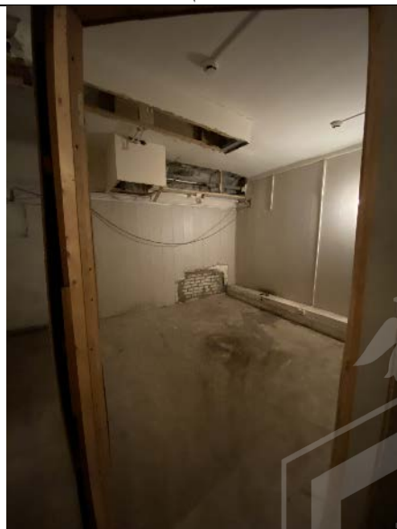
Фото № 18 – Внутреннее состояние помещения 4-Н
