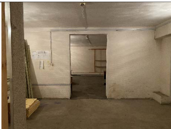
Фото № 23 – Внутреннее состояние помещения 4-Н
