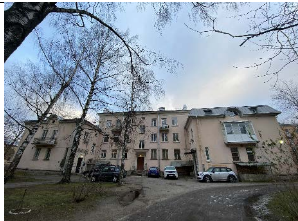
Фото № 1 – Здание, в котором находится Объект оценки
