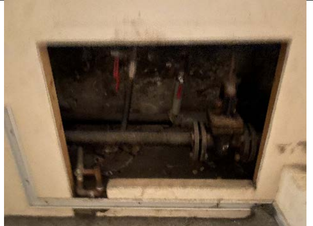
Фото № 26 – Внутреннее состояние помещения 4-Н
