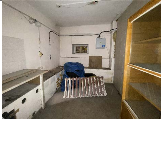
Фото № 16 – Внутреннее состояние помещения 4-Н
