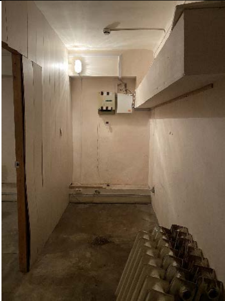
Фото № 21 – Внутреннее состояние помещения 4-Н
