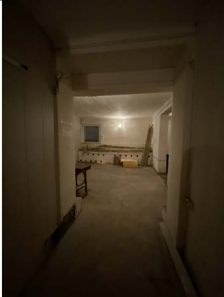
Фото № 19 – Внутреннее состояние помещения 4-Н
