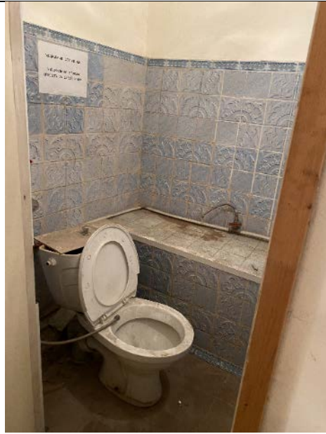
Фото № 14 – Внутреннее состояние помещения 4-Н
