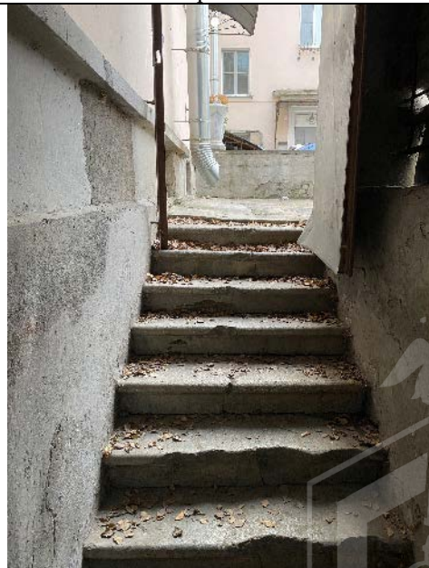
Фото № 6 – Вход в помещение 4-Н
