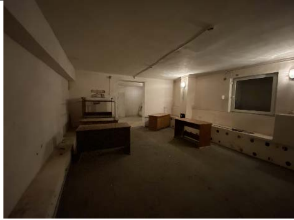
Фото № 25 – Внутреннее состояние помещения 4-Н
