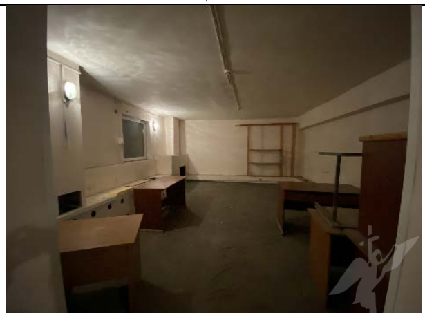
Фото № 24 – Внутреннее состояние помещения 4-Н
