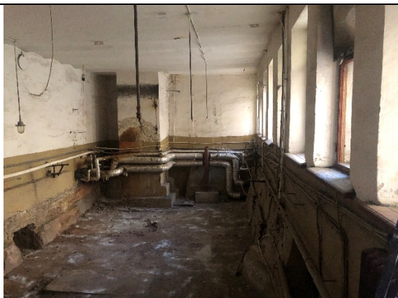
Фото № 7 - Внутренне состояние
