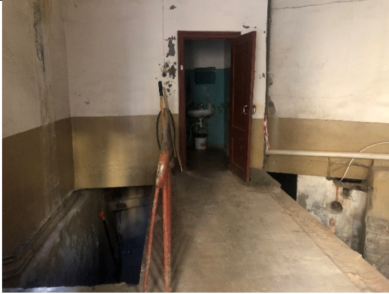
Фото № 9 - Внутренне состояние
