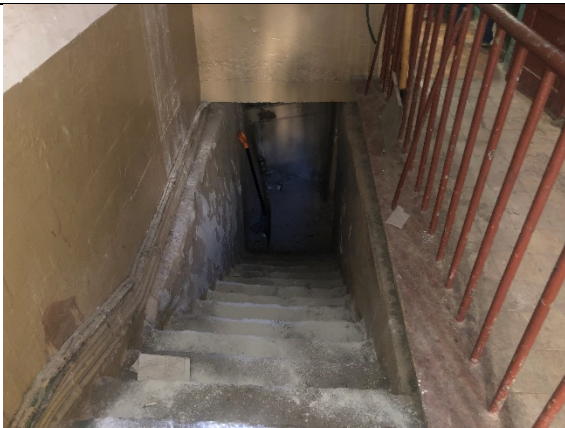
Фото № 13 – Спуск в подвал
