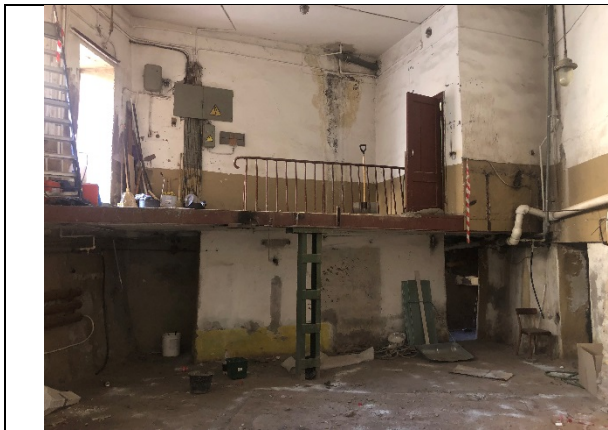
Фото № 17 – Внутреннее состояние
