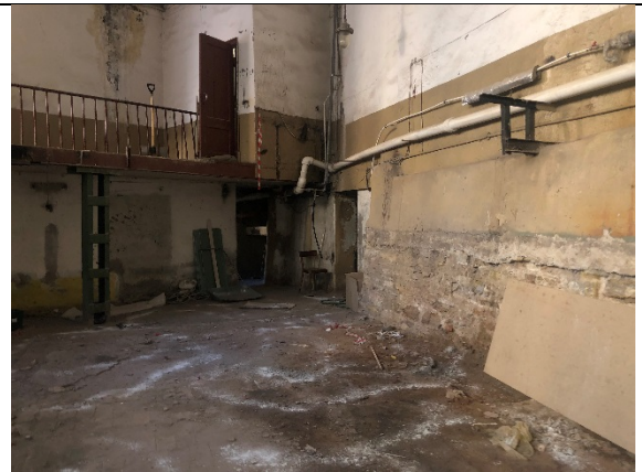
Фото № 14 – Внутреннее состояние
