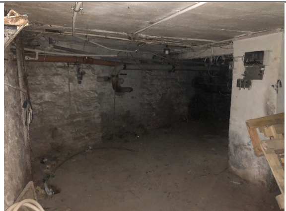
Фото № 20 - Внутренний вид подвала
