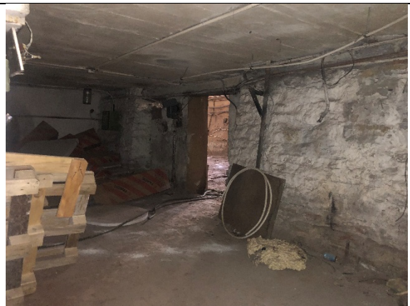
Фото № 18 – Внутренний вид подвала
