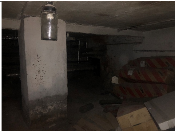
Фото № 19 – Внутренний вид подвала
