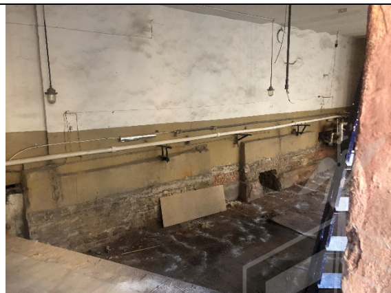
Фото № 8 - Внутренне состояние
