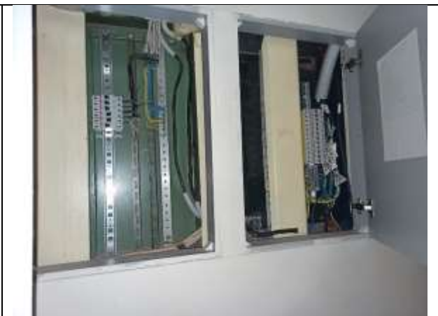
Фото 28. Внутреннее состояние Объекта оценки
