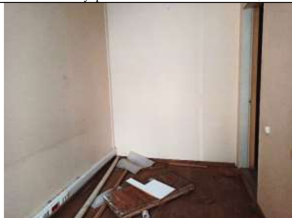
Фото 18. Внутреннее состояние Объекта оценки
