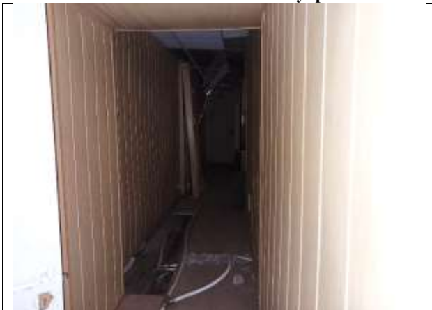
Фото 13. Внутреннее состояние Объекта оценки
