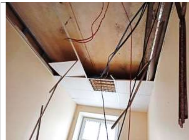
Фото 27. Внутреннее состояние Объекта оценки
