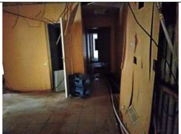
Фото 20. Внутреннее состояние Объекта оценки
