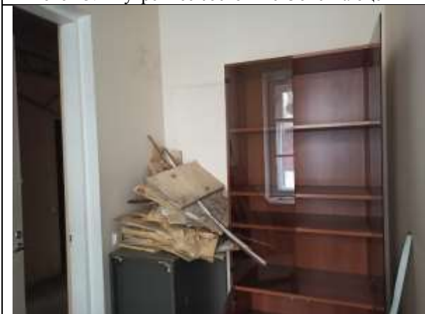
Фото 25. Внутреннее состояние Объекта оценки
