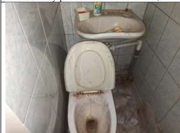
Фото 33. Внутреннее состояние Объекта оценки
