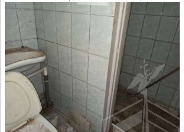
Фото 34. Внутреннее состояние Объекта оценки
