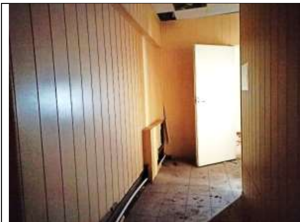
Фото 19. Внутреннее состояние Объекта оценки
