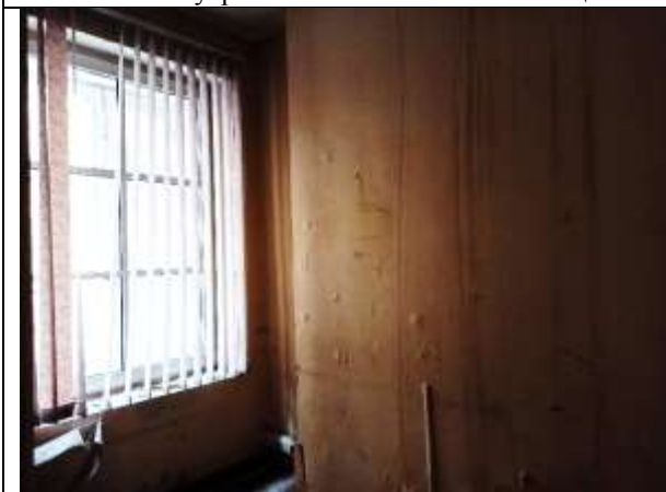
Фото 29. Внутреннее состояние Объекта оценки
