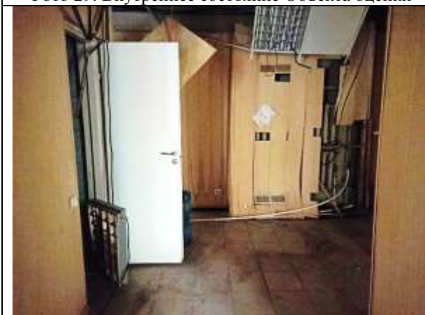
Фото 31. Внутреннее состояние Объекта оценки
