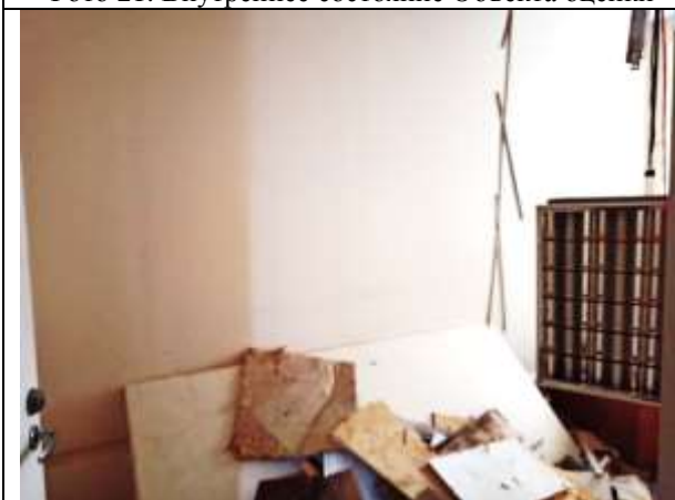
Фото 23. Внутреннее состояние Объекта оценки
