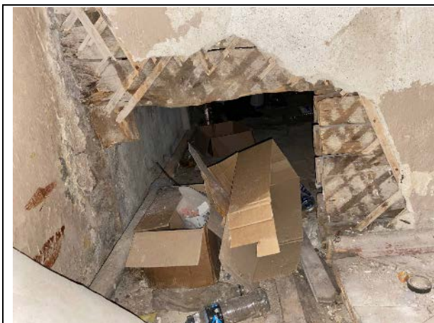
Фото № 11 – Внутреннее состояние помещения 5-Н
