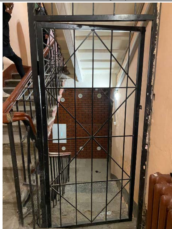
Фото № 7 – Проход к помещению 5-Н
