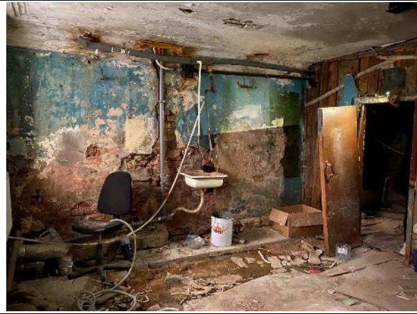
Фото № 9 – Внутреннее состояние помещения 5-Н
