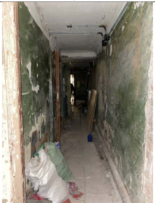
Фото № 11 – Внутреннее состояние помещения 5-Н
