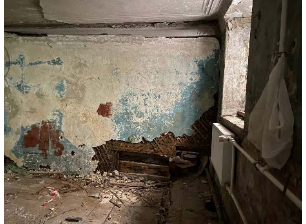
Фото № 10 – Внутреннее состояние помещения 5-Н
