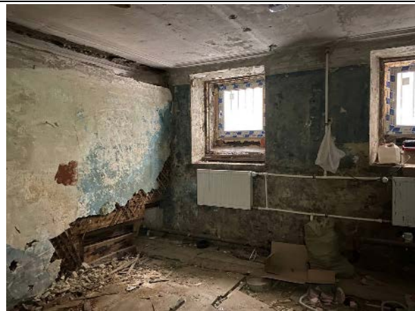
Фото № 11 – Внутреннее состояние помещения 5-Н
