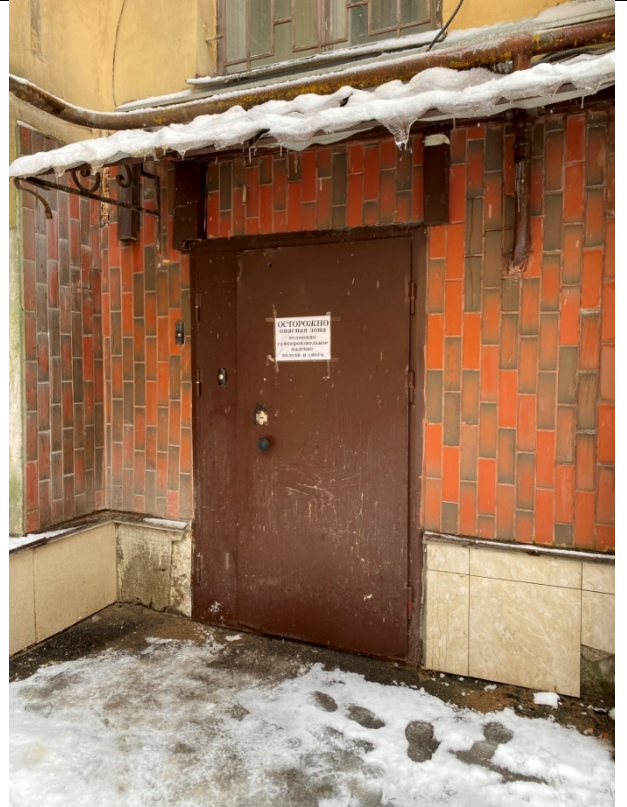
Фото № 4 – Вход в помещение со двора
