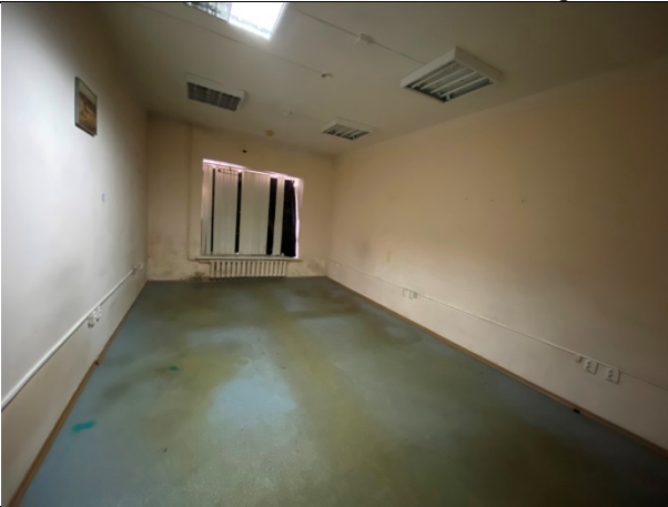
Фото № 11 – Внутреннее состояние помещения
