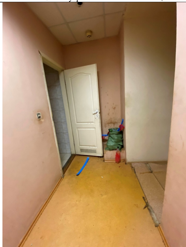
Фото № 18 – Внутреннее состояние помещения
