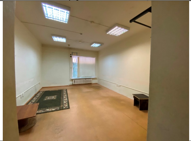
Фото № 12 – Внутреннее состояние помещения
