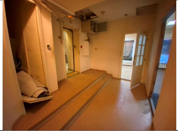
Фото № 10 – Внутреннее состояние помещения
