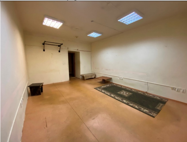
Фото № 13 – Внутреннее состояние помещения
