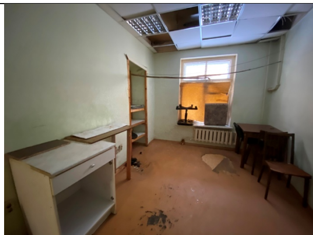
Фото № 16 – Внутреннее состояние помещения
