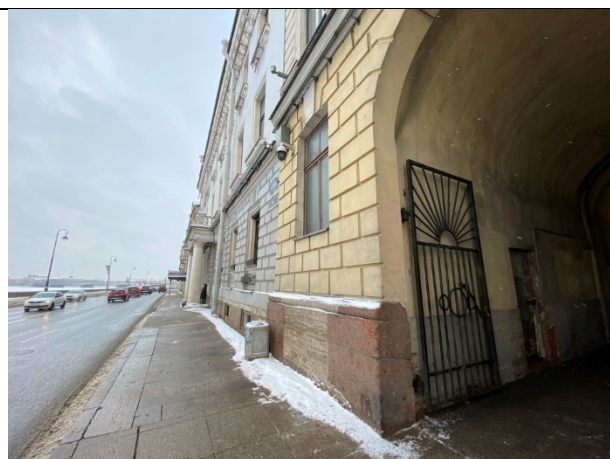
Фото № 2 – Ближайшее окружение и подъездные пути
