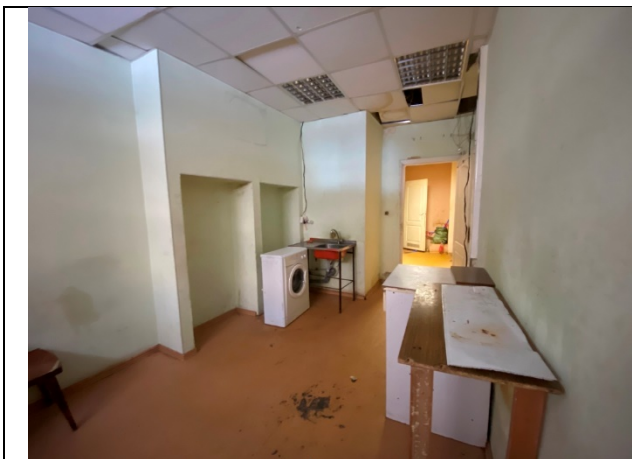
Фото № 15 – Внутреннее состояние помещения
