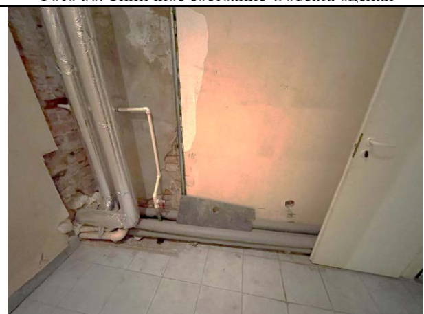
Фото 38. Типичное состояние Объекта оценки
