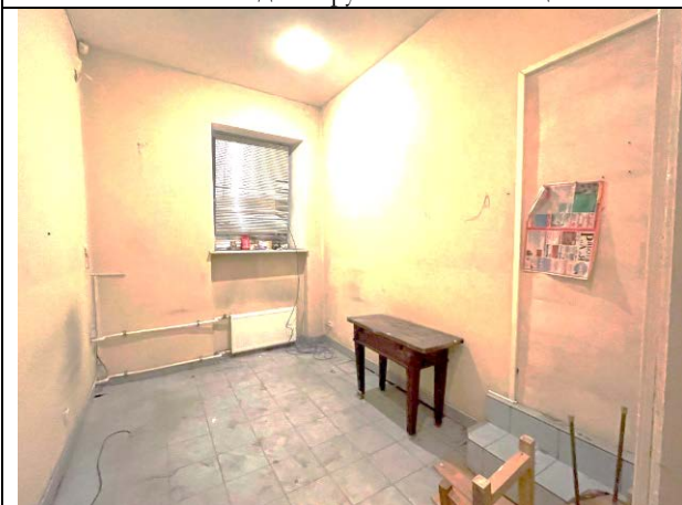
Фото 27. Типичное состояние Объекта оценки
