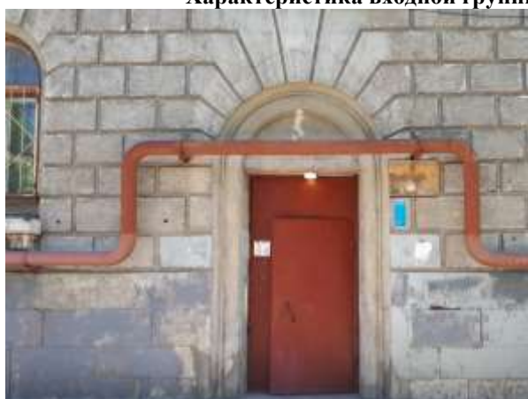
Фото 3. Общий вход со двора
