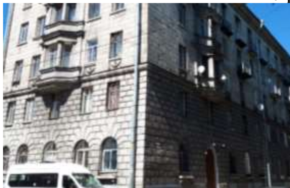
Фото 1. Вид здания, в котором расположен Объект оценки
