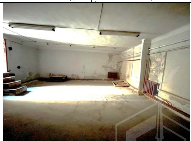
Фото 22. Типичное состояние Объекта оценки
