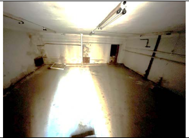
Фото 24. Типичное состояние Объекта оценки
