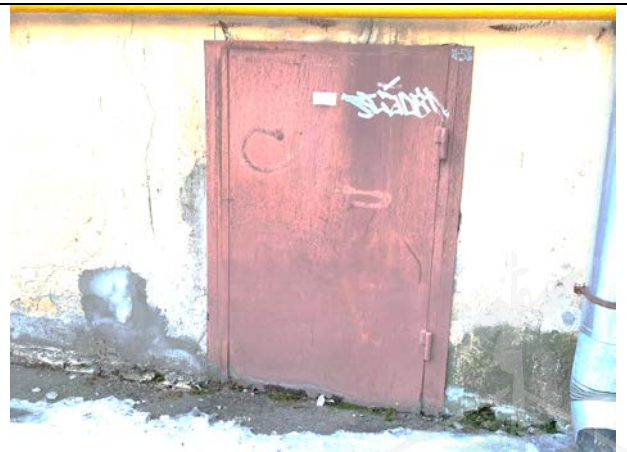
Фото 30. Входная группа Объекта оценки, второй отдельный вход со двора
