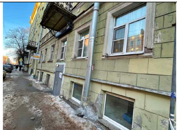
Фото 16. Вид здания расположения Объекта оценки
