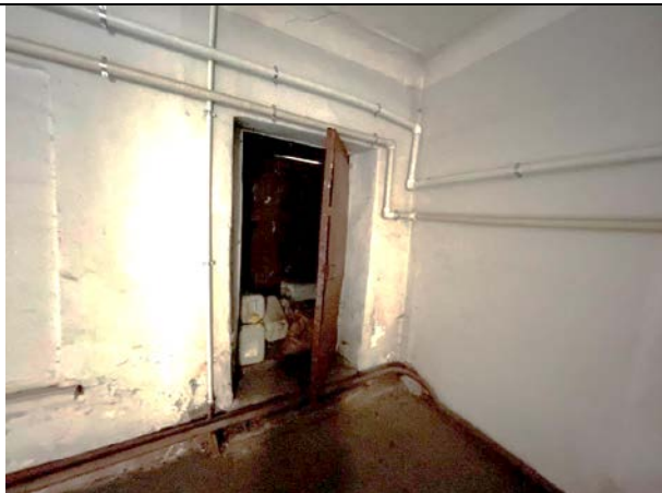
Фото 29. Входная группа Объекта оценки, второй отдельный вход со двора
