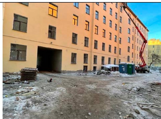
Фото 32. Входная группа Объекта оценки, второй отдельный вход со двора
