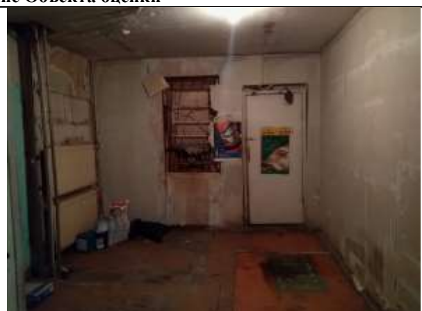
Фото 12. Внутреннее состояние Объекта оценки
