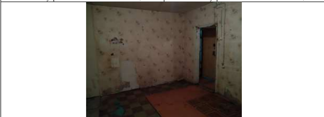
Фото 17. Внутреннее состояние Объекта оценки
