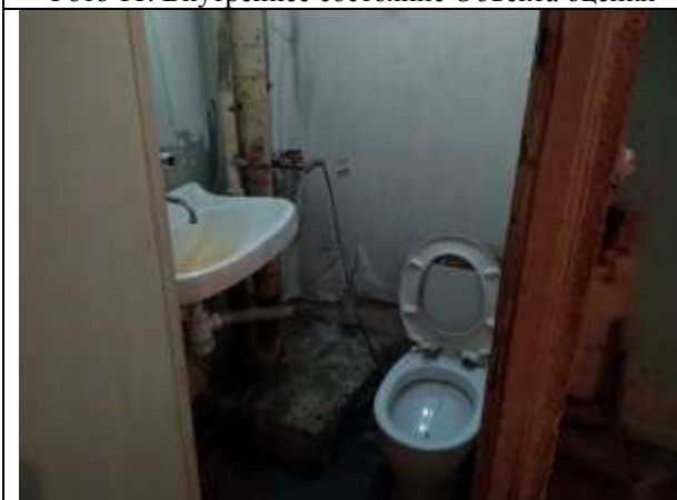
Фото 13. Внутреннее состояние Объекта оценки
