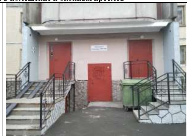
Фото 8. Общий вход с улицы
