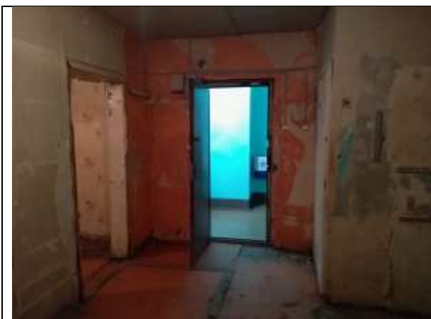
Фото 15. Внутреннее состояние Объекта оценки
