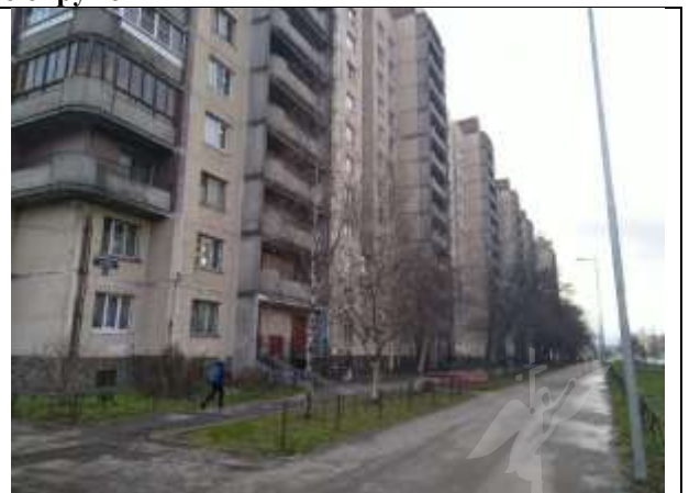
Фото 2. Вид здания, в котором расположен Объект оценки
