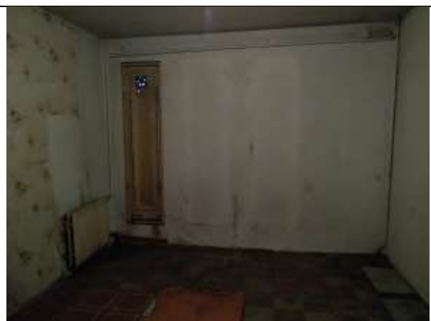
Фото 16. Внутреннее состояние Объекта оценки
