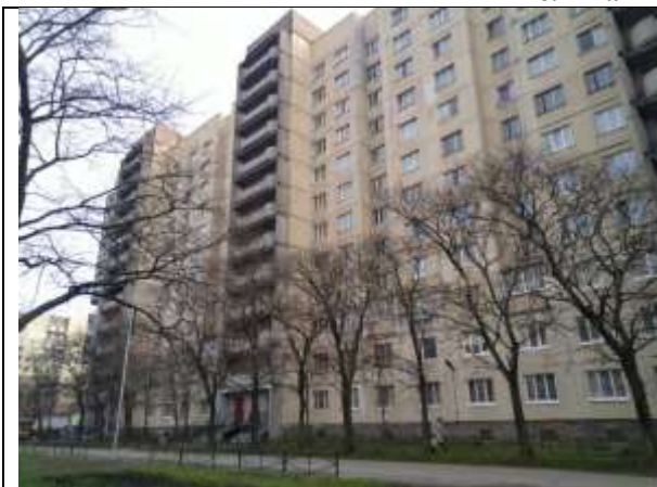
Фото 1. Вид здания, в котором расположен Объект оценки
