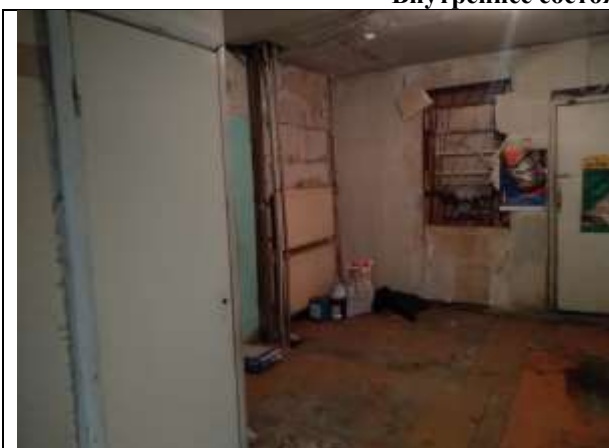
Фото 11. Внутреннее состояние Объекта оценки
