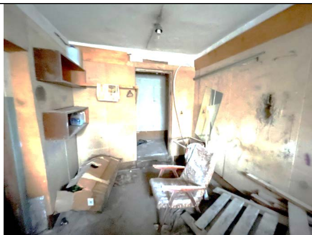
Фото 41. Типичное состояние Объекта оценки
