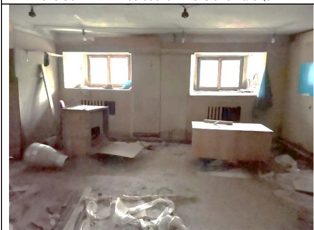
Фото 38. Типичное состояние Объекта оценки
