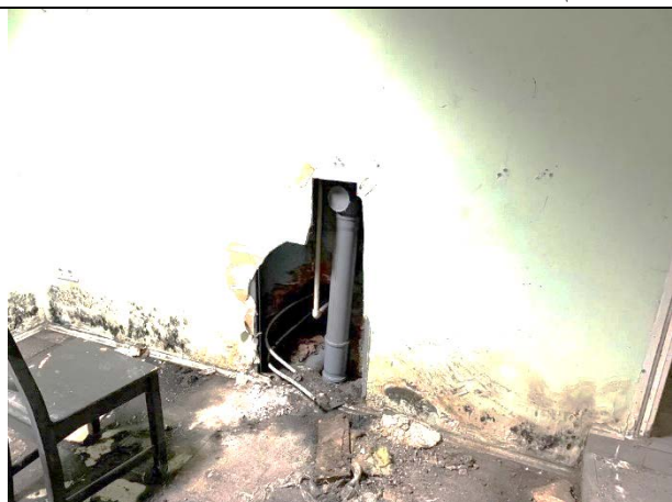
Фото 37. Типичное состояние Объекта оценки
