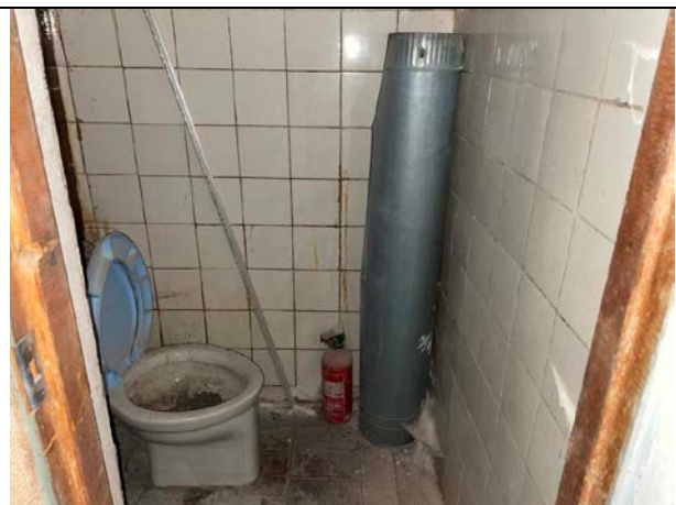
Фото 49. Типичное состояние Объекта оценки
