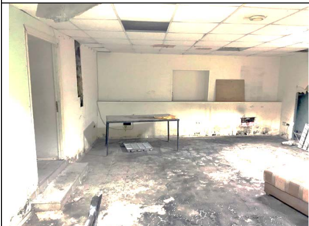
Фото 34. Типичное состояние Объекта оценки
