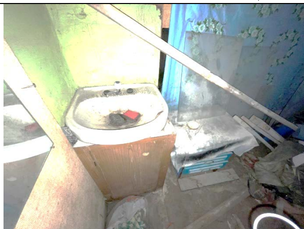
Фото 45. Типичное состояние Объекта оценки
