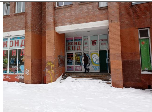
Фото № 14 – Оконные проемы, входы в помещение
