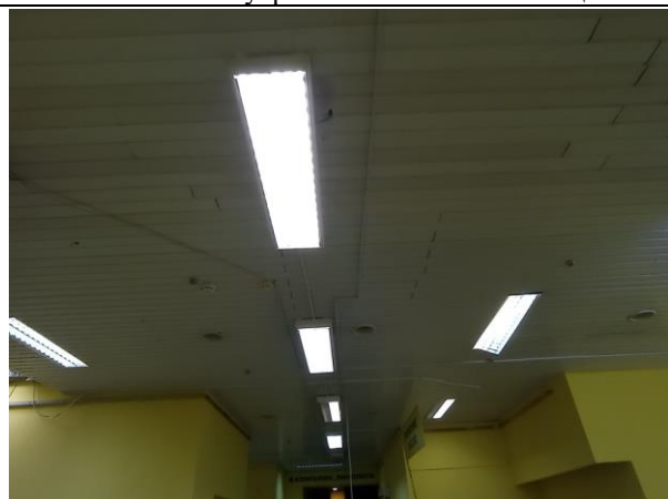
Фото № 51 – Внутреннее состояние помещения
