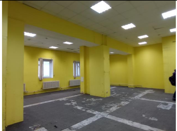
Фото № 56 – Внутреннее состояние помещения
