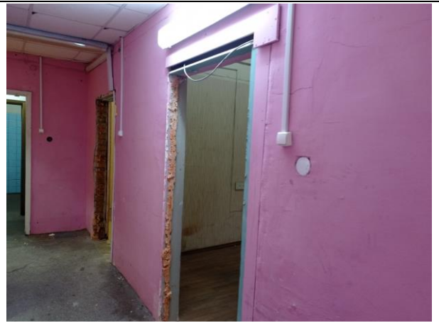
Фото № 22 – Внутреннее состояние помещения
