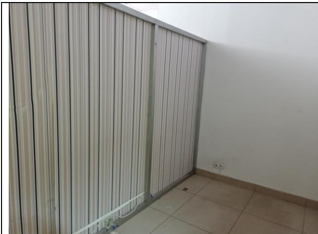
Фото № 61 – Внутреннее состояние помещения
