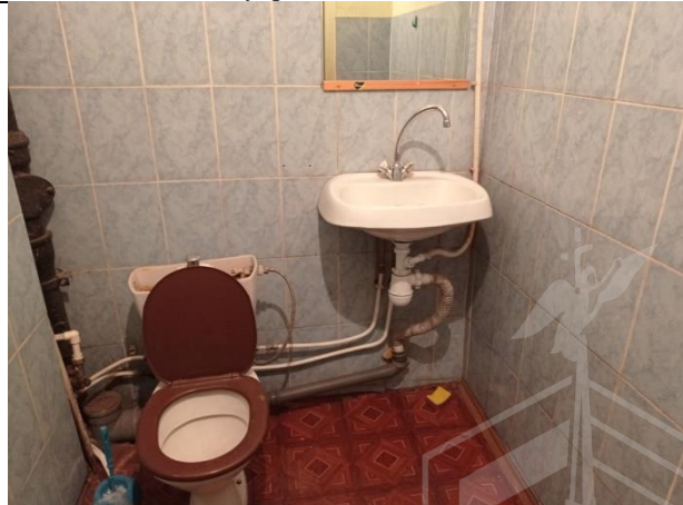
Фото № 60 – Внутреннее состояние помещения
