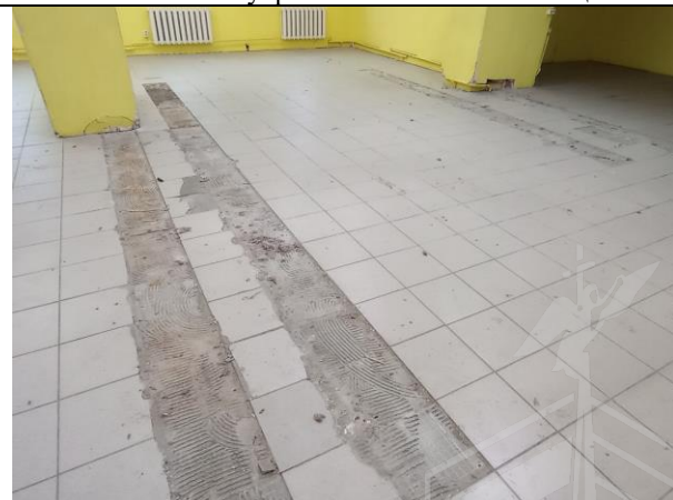
Фото № 52 – Внутреннее состояние помещения
