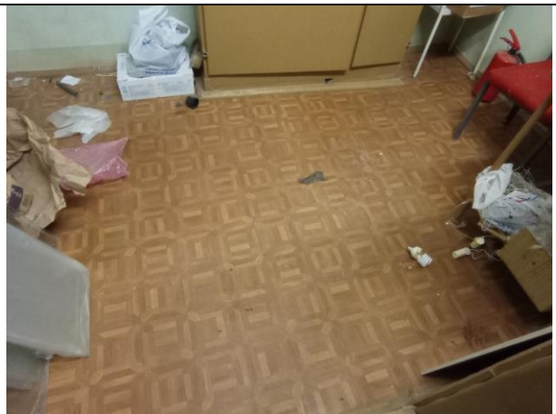
Фото № 54 – Внутреннее состояние помещения
