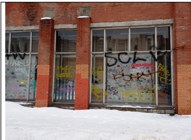
Фото № 13 – Оконные проемы, входы в помещение
