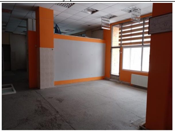
Фото № 33 – Внутреннее состояние помещения
