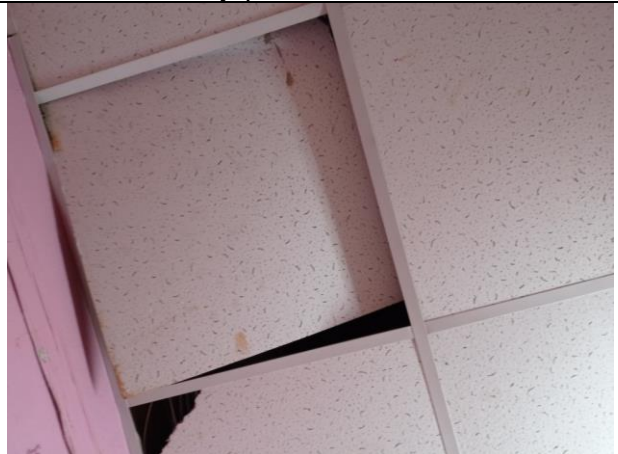
Фото № 24 – Внутреннее состояние помещения
