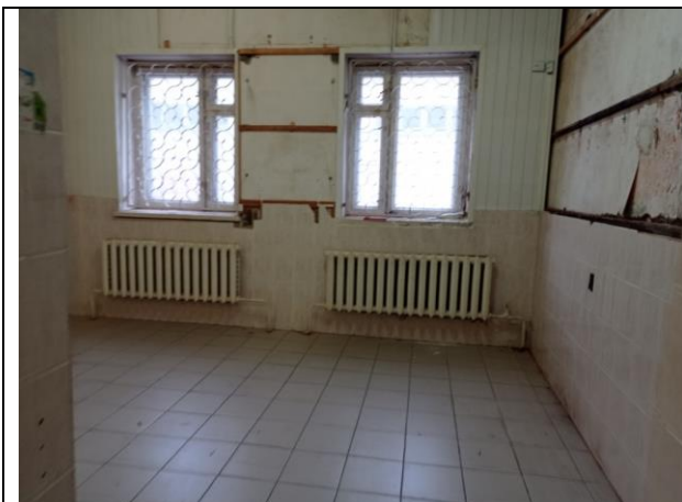
Фото № 29 – Внутреннее состояние помещения
