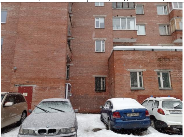
Фото № 8 – Оконные проемы, входы в помещение
