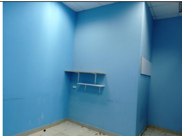
Фото № 38 – Внутреннее состояние помещения
