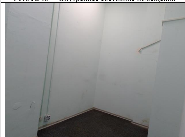
Фото № 65 – Внутреннее состояние помещения
