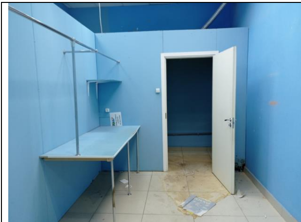
Фото № 37 – Внутреннее состояние помещения
