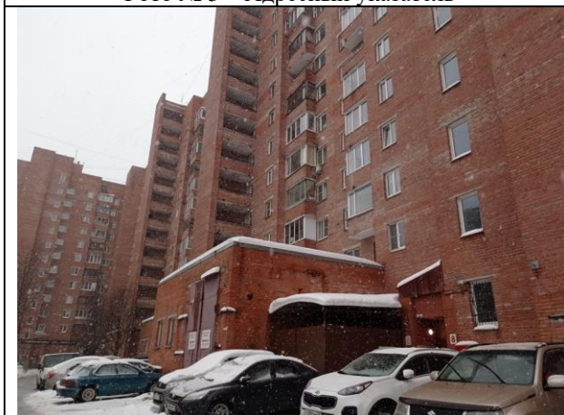
Фото № 7 – Оконные проемы, входы в помещение
