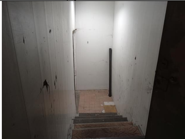
Фото № 59 – Внутреннее состояние помещения
