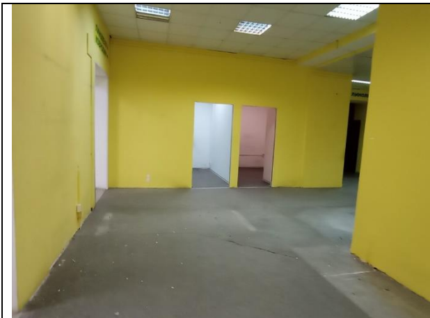
Фото № 53 – Внутреннее состояние помещения
