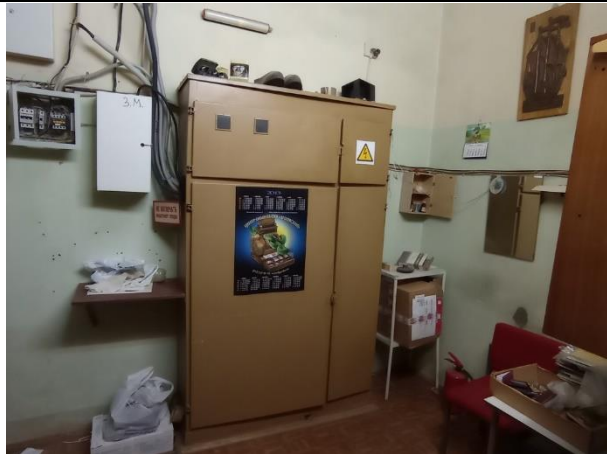
Фото № 55 – Внутреннее состояние помещения
