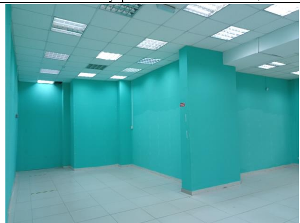
Фото № 40 – Внутреннее состояние помещения
