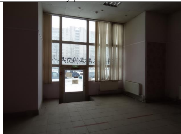
Фото № 48 – Внутреннее состояние помещения
