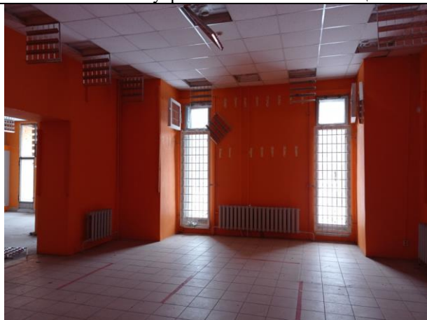
Фото № 31 – Внутреннее состояние помещения
