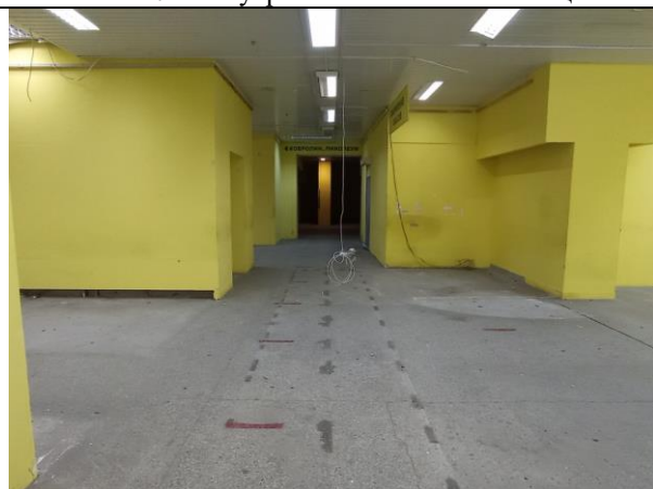
Фото № 49 – Внутреннее состояние помещения
