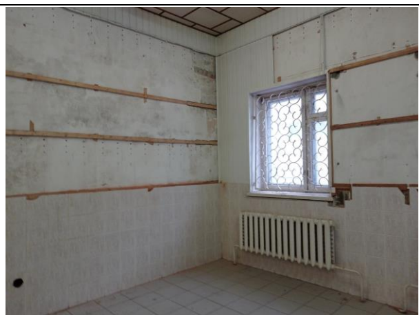
Фото № 30 – Внутреннее состояние помещения
