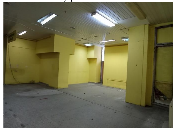
Фото № 50 – Внутреннее состояние помещения
