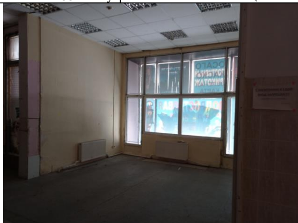
Фото № 35 – Внутреннее состояние помещения
