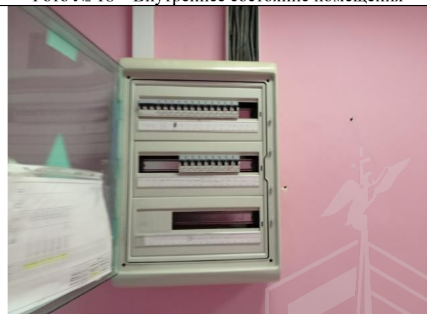
Фото № 20 – Внутреннее состояние помещения
