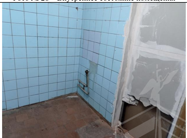
Фото № 28 – Внутреннее состояние помещения
