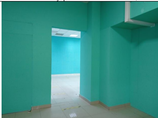
Фото № 39 – Внутреннее состояние помещения
