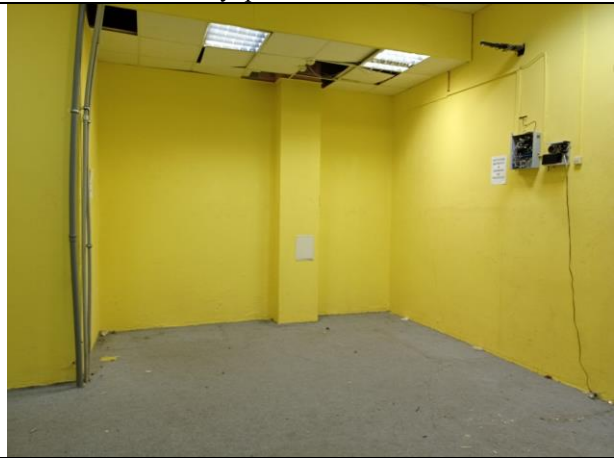
Фото № 58 – Внутреннее состояние помещения
