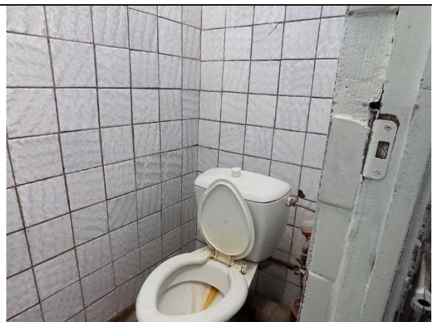
Фото № 46 – Внутреннее состояние помещения
