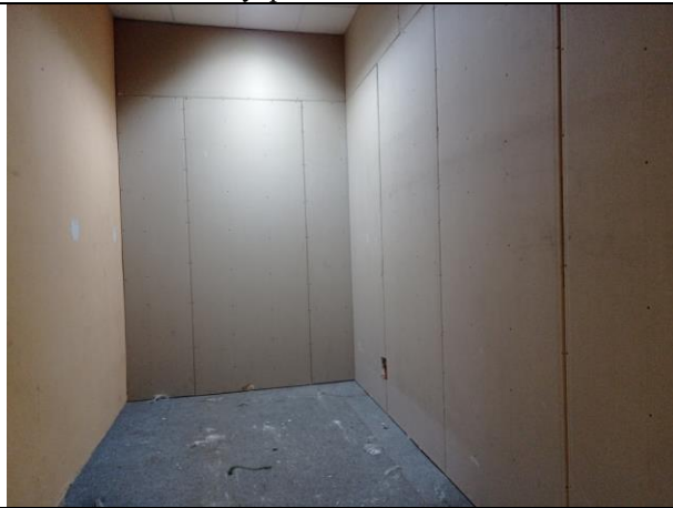
Фото № 57 – Внутреннее состояние помещения
