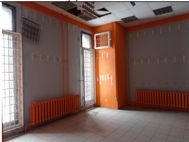
Фото № 32 – Внутреннее состояние помещения
