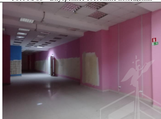
Фото № 68 – Внутреннее состояние помещения
