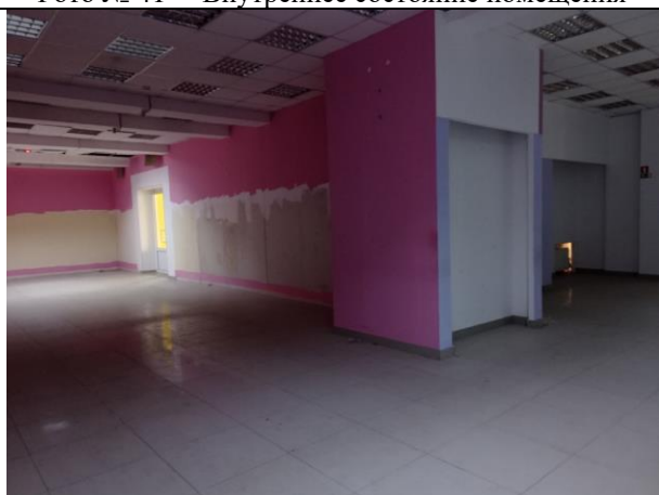
Фото № 43 – Внутреннее состояние помещения
