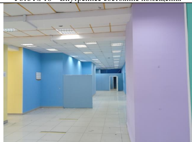
Фото № 18 – Внутреннее состояние помещения
