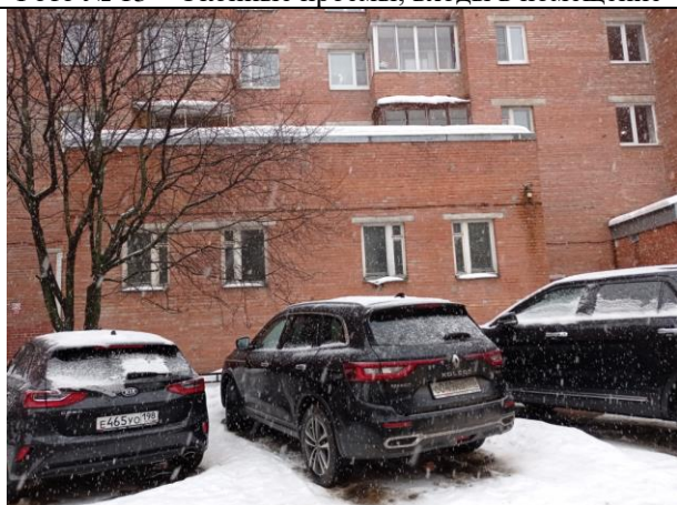
Фото № 15 – Оконные проемы, входы в помещение
