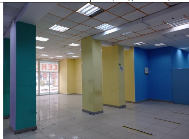
Фото № 16 – Внутреннее состояние помещения
