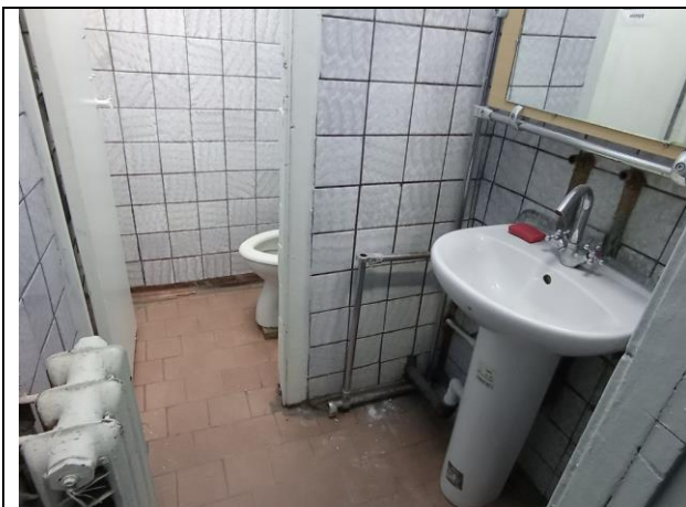
Фото № 45 – Внутреннее состояние помещения
