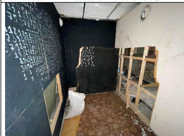
Фото 37. Типичное состояние Объекта оценки
