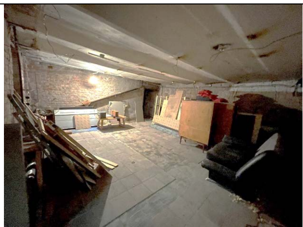
Фото 32. Типичное состояние Объекта оценки
