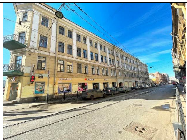
Фото 16. Вид здания расположения Объекта оценки
