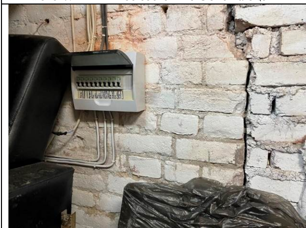
Фото 49. Типичное состояние Объекта оценки
