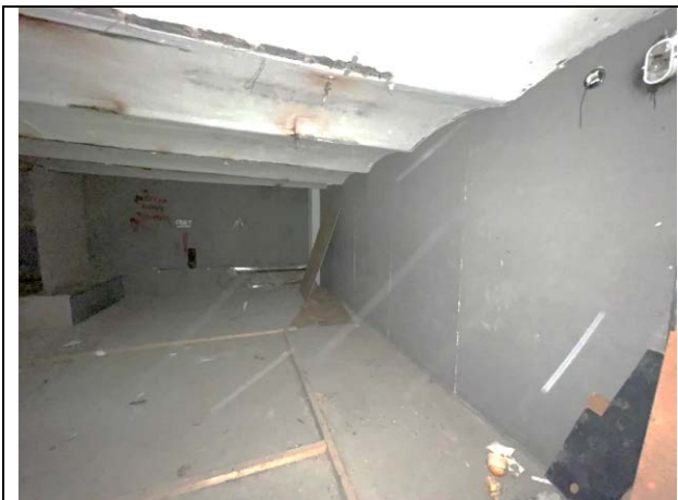
Фото 39. Типичное состояние Объекта оценки
