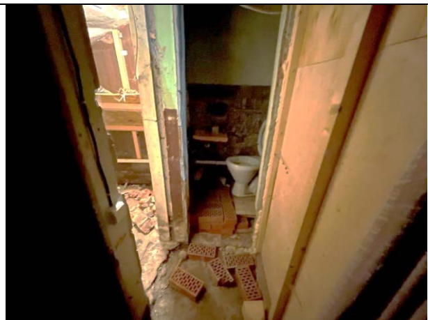
Фото 48. Типичное состояние Объекта оценки
