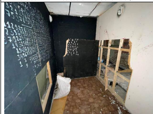
Фото 37. Типичное состояние Объекта оценки
