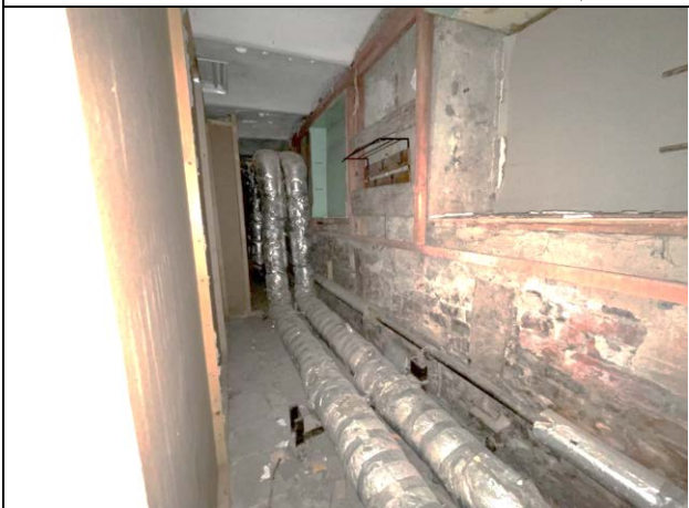
Фото 41. Типичное состояние Объекта оценки
