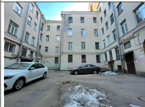
Фото 21. Внутри дворовая территория Объекта оценки
