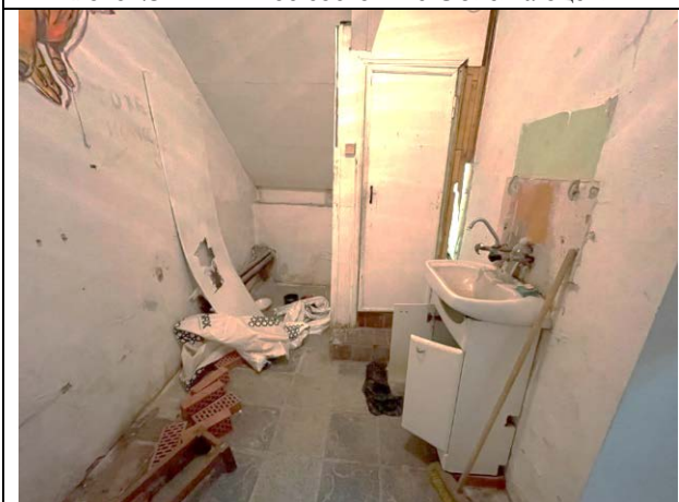
Фото 45. Типичное состояние Объекта оценки
