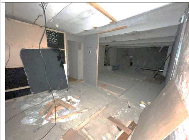
Фото 35. Типичное состояние Объекта оценки
