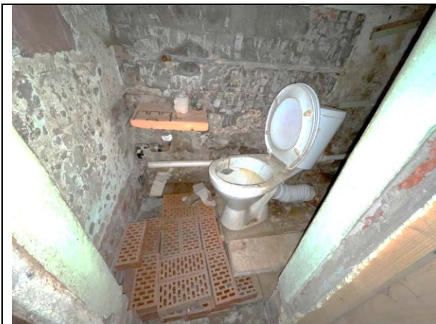
Фото 47. Типичное состояние Объекта оценки
