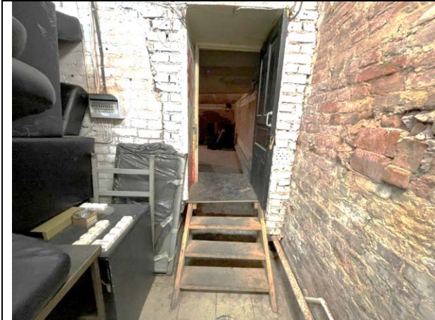
Фото 33. Типичное состояние Объекта оценки
