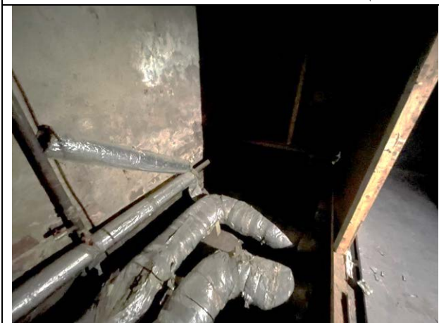
Фото 43. Типичное состояние Объекта оценки
