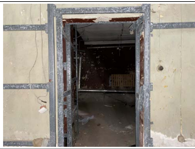
Фото № 8 – Внутреннее состояние
