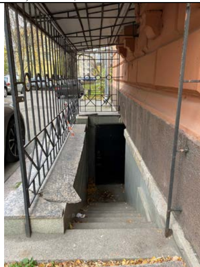
Фото № 2 – Вход в помещение осуществляется со двора через приямок
