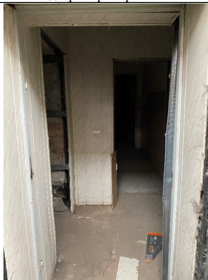
Фото № 4 – Внутреннее состояние
