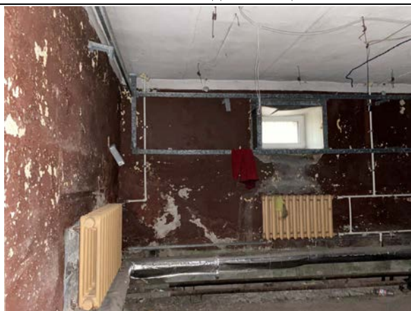
Фото № 5 – Внутреннее состояние
