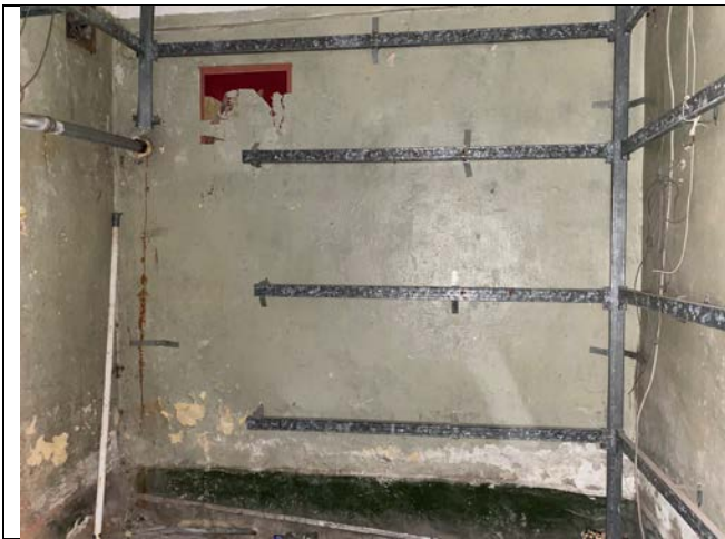
Фото № 7 – Внутреннее состояние
