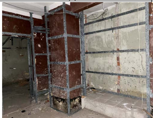
Фото № 9 – Внутреннее состояние
