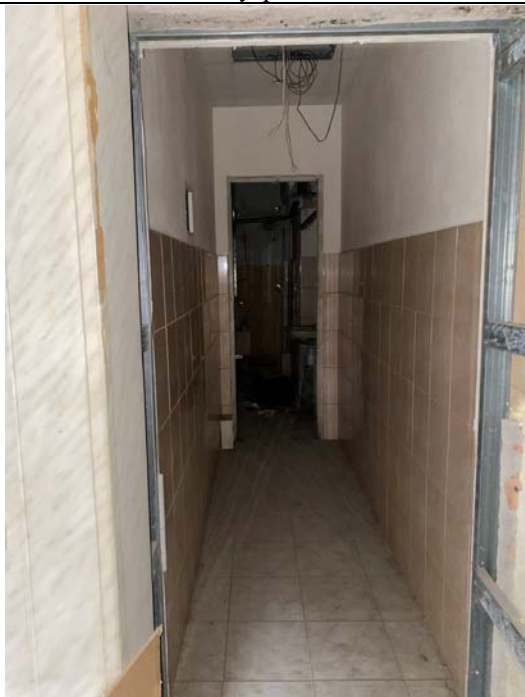
Фото № 11 – Внутреннее состояние
