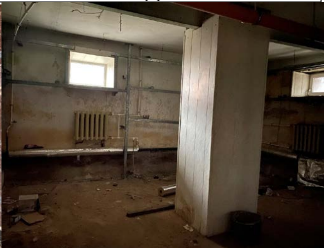
Фото № 10 – Внутреннее состояние
